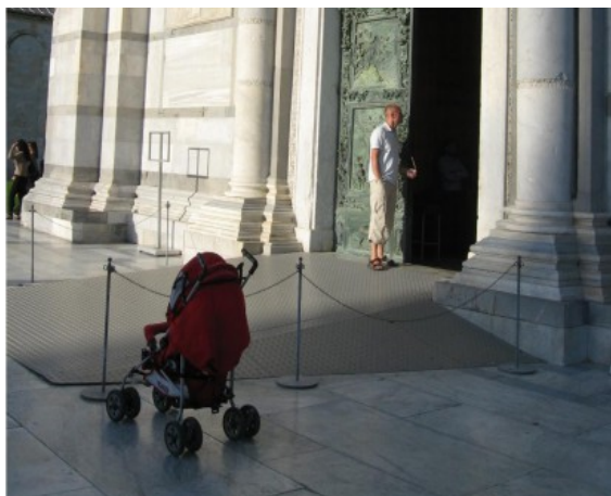
Рис.4. Пример оборудования временного пандуса для обеспечения доступа в здание, являющегося памятником архитектуры[25]
