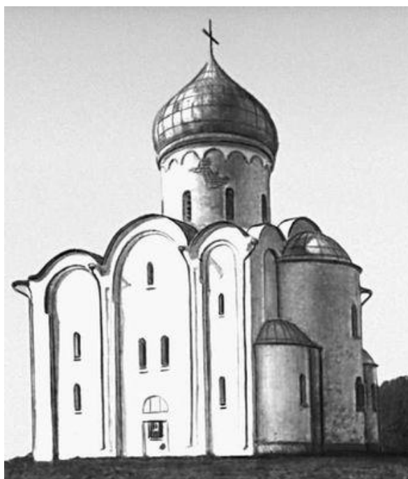
Рис. 16. Нередицкая церковь после восстановительно-реставрационных работ 156 .
