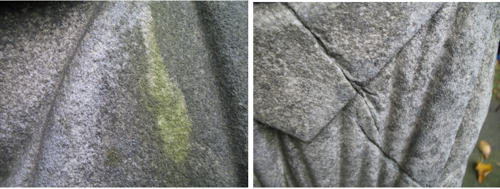
Рис. 3. Колонии темноокрашенных грибов и налет водорослей на поверхности мрамора статуи.
