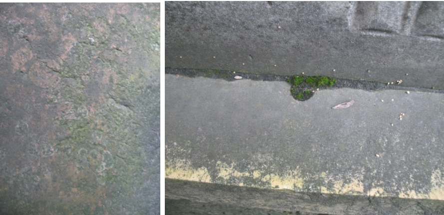
Рис. 4 Слоевища накипных лишайников и колонии темноокрашенных грибов на поверхности мрамора статуи.
