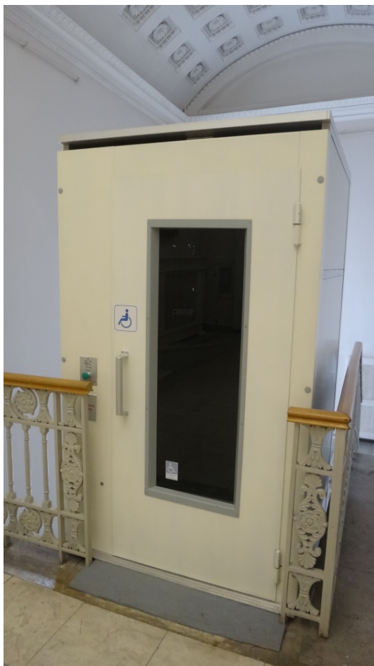
Рис. Б.6 и Б.7 Лифт для инвалидов. Корпус Бенуа
