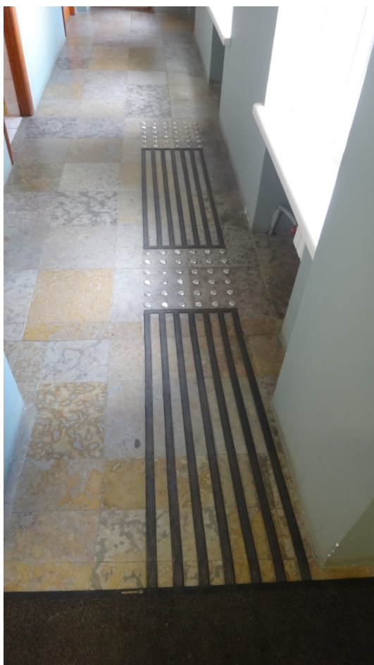
Рис. Д.19 Тактильное напольное покрытие
