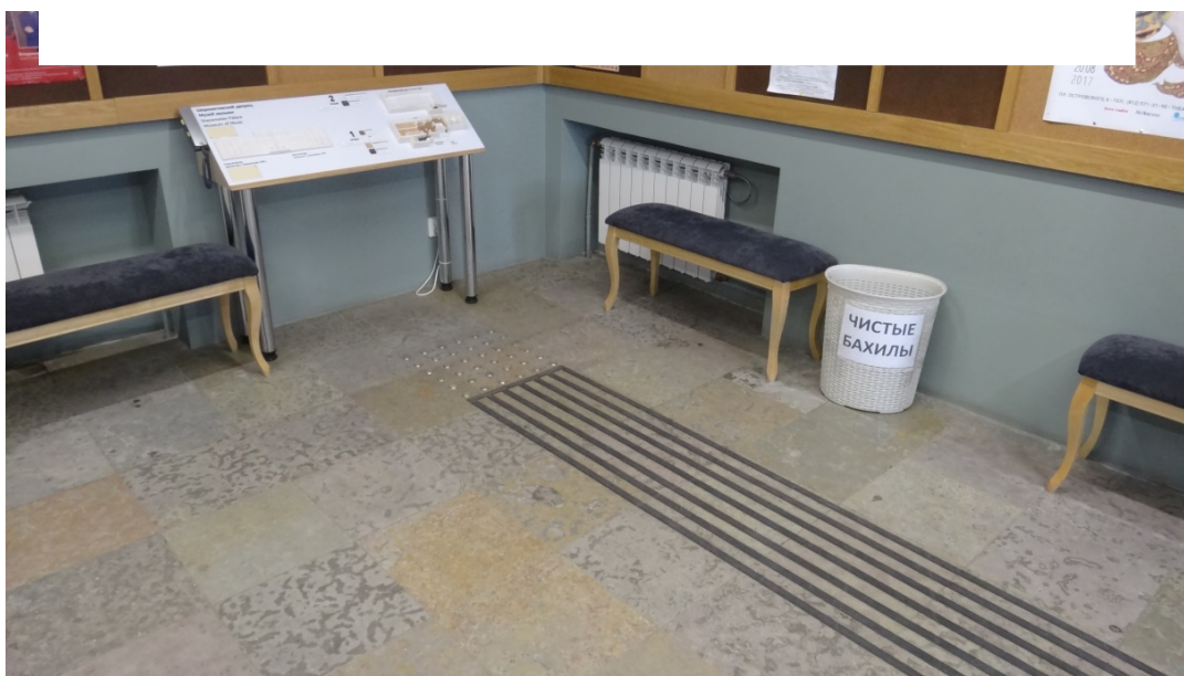
Рис. Д.18 Тактильное напольное покрытие
