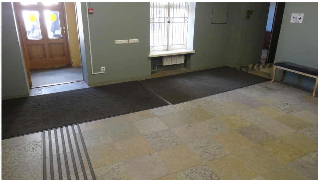
Рис. Д.17 Тактильное напольное покрытие, перекрытое половиками
