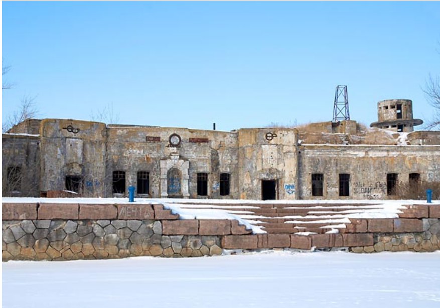
Рис. 1. Форт «Обручев», вид на центральную часть батареи
