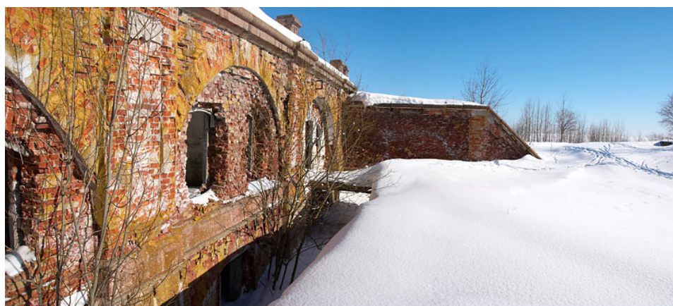
Рис. 3. Морская южная батарея № 1. Горжева часть казематированного траверса
