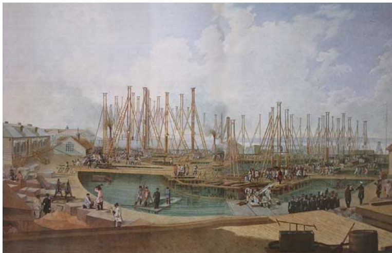
Рис. 2. Строительство форта «Павел I»
