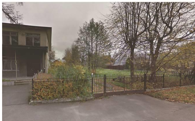
Рис. Вид на госпиталь ул. Полевая 16
