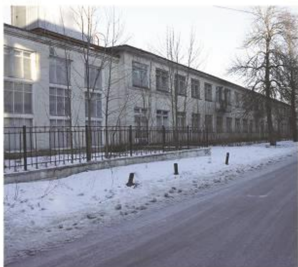
Рис. Вид на госпиталь ул. Полевая 16
