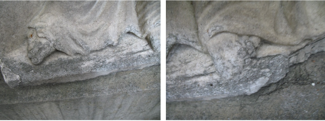
Рис. 2. Колонии темноокрашенных грибов в зонах выкрашивания мрамора.
