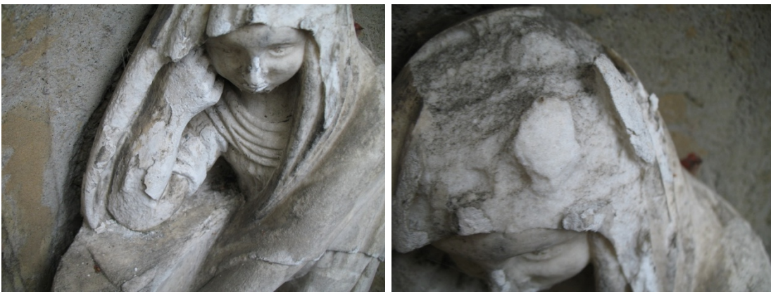
Рис. 3. Потеря элементов камня в результате отслаивания гипсовой корки с поверхности мрамора. Грязевые отложения на поверхности мрамора.
