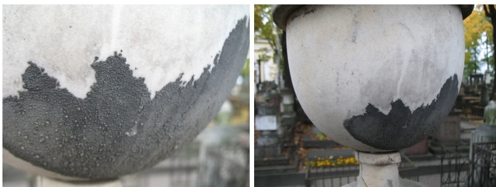
Рис. 3. Гипсовая корка на поверхности мрамора вазы-светильника.
