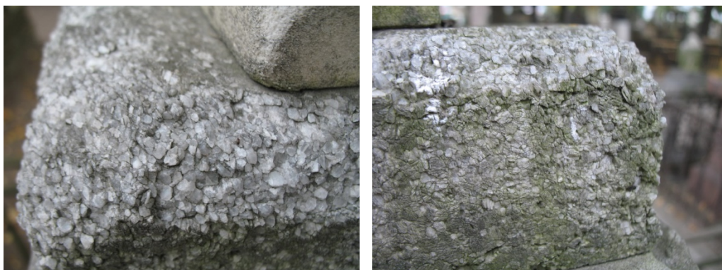
Рис. 2. Колонии темноокрашенных грибов и налет водорослей на поверхности крупнозернистого мрамора плинта.
