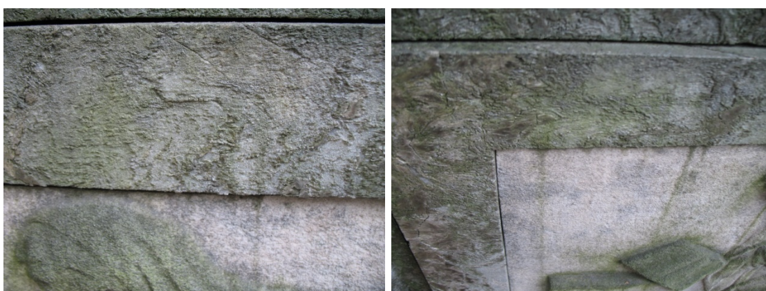
Рис. 6. Колонии темноокрашенных грибов и налет водорослей на поверхности рускеальского мрамора вокруг доски с рельефом.
