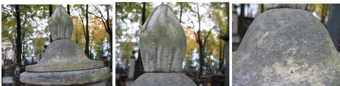
Рис. 4. Колонии темноокрашенных грибов и налет водорослей на поверхности мрамора вазы-светильника.
