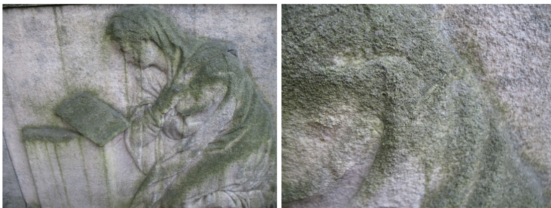
Рис. 5. Колонии темноокрашенных грибов и налет водорослей на поверхности мрамора доски с рельефом.
