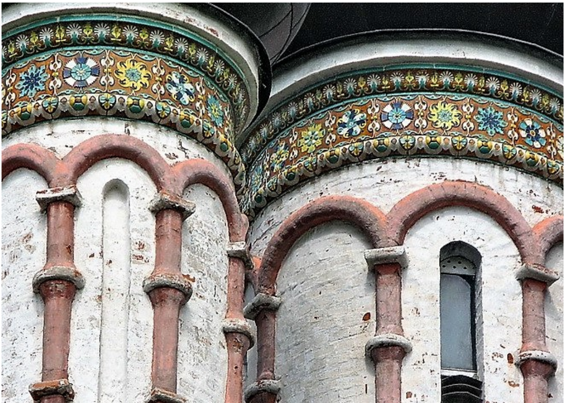
Илл. 42. Церковь Спаса Нерукотворного Образа в с. Спас-Сетунь. 1676. Изразцовый декор барабанов. Фотография 2016 г.
