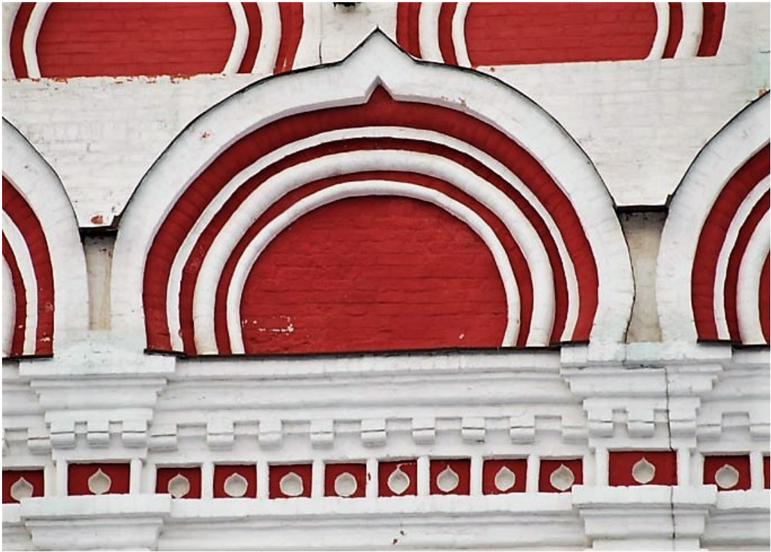
Илл. 43. Церковь Тихвинской иконы Божией Матери в Алексеевском. 1680. Пояс из ширинок. Фотография 2015 г.
