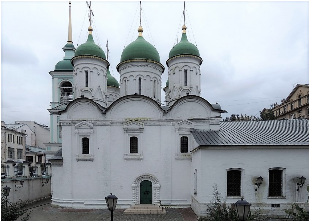
Илл. 5. Церковь Троицы Живоначальной в Листах. 1650-1661. Северный фасад. Фотография 2016 г.
