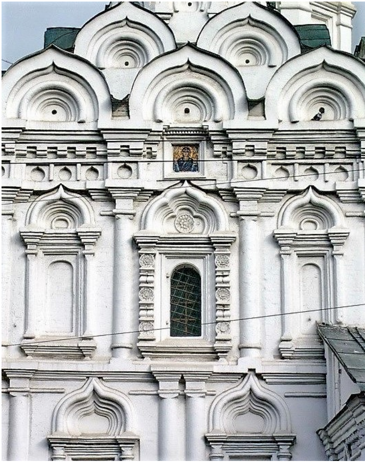
Илл. 3 Церковь Рождества Богородицы в Путинках в Москве. 1649-1652. Западный фасад. Фотография 2014 г.
