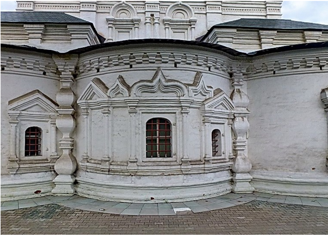
Илл. 27. Церковь Николая Чудотворца в Пыжах. 1672. Восточный фасад. Фотография 2016 г.
