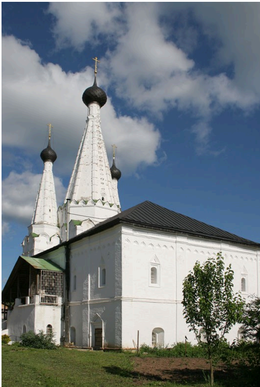
2. Успенская «Дивная» церковь в Алексеевском монастыре. Углич. Ярославль. 1638-1639 гг. http://www.temples.ru/show_picture? PictureID=42156 Фото 2008 г.
