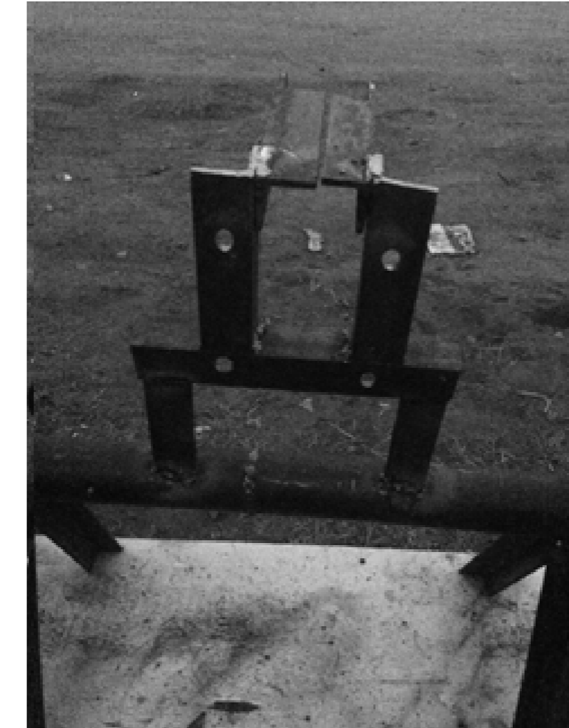
14. Приваривание вакуумного усилителя
