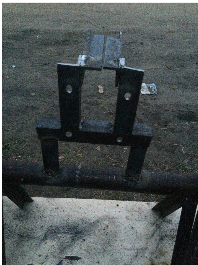
Рисунок 1.16 – Приваривание крепления вакуумного усилителя
