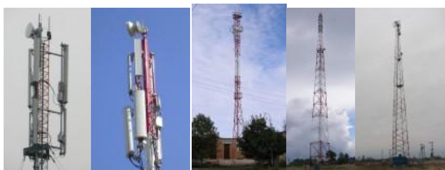
Рисунок 3.2 – Разновидности вышек для BTS на открытой местности
