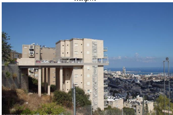
Рис. 39. Вертикальный лифт в здании
