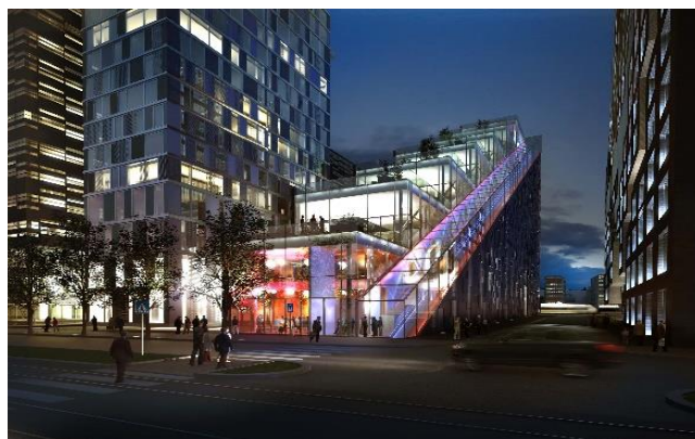
Рис. 40. Наклонный лифт в здании
