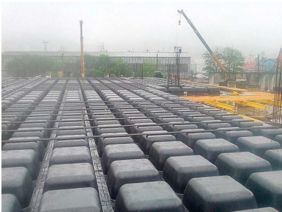
*Рис 16. Раскладка опалубочной формы*
