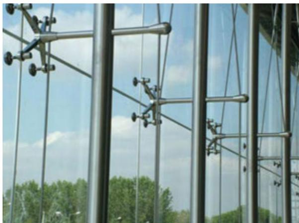
*Рис. 19. Спайдерная система с несущими металлическими опорами*
