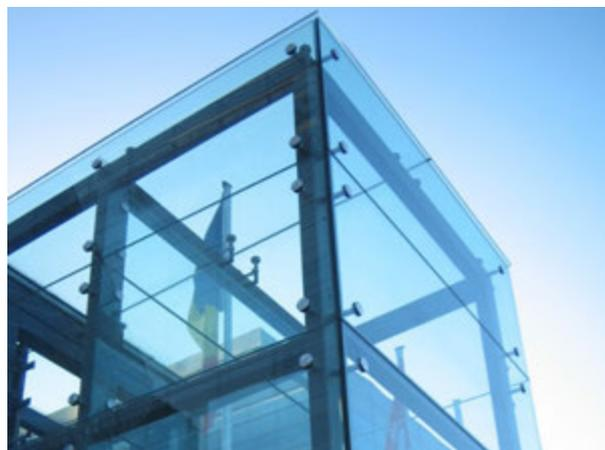
*Рис. 20. Остекление фасадов планарной системой*
