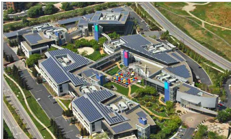
Рис. 23. Googleplex. Cupertino. California
