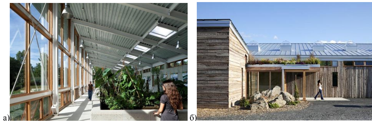
Рис. 37. Omega Center-очистное сооружение-общественный центр. г.Ринебек, Нью-Йорк, США[6]: а) Внутреннее пространство б) Входная зона
