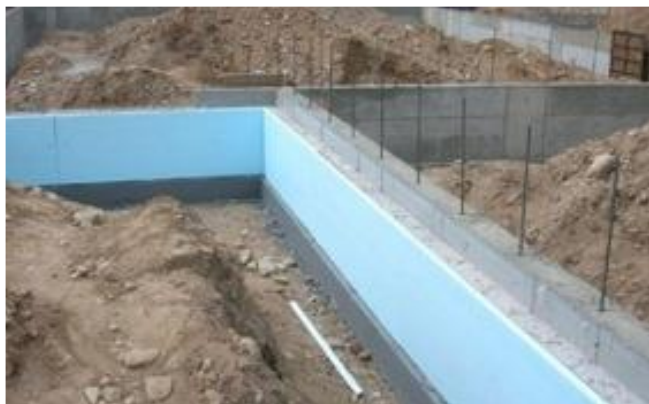
Рис. 2.2 - Утепление фундамента плитами пенополистирола
