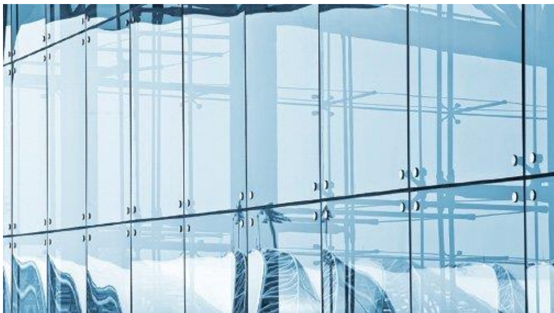
Рис. 2.6 – Спайдерное остекление
