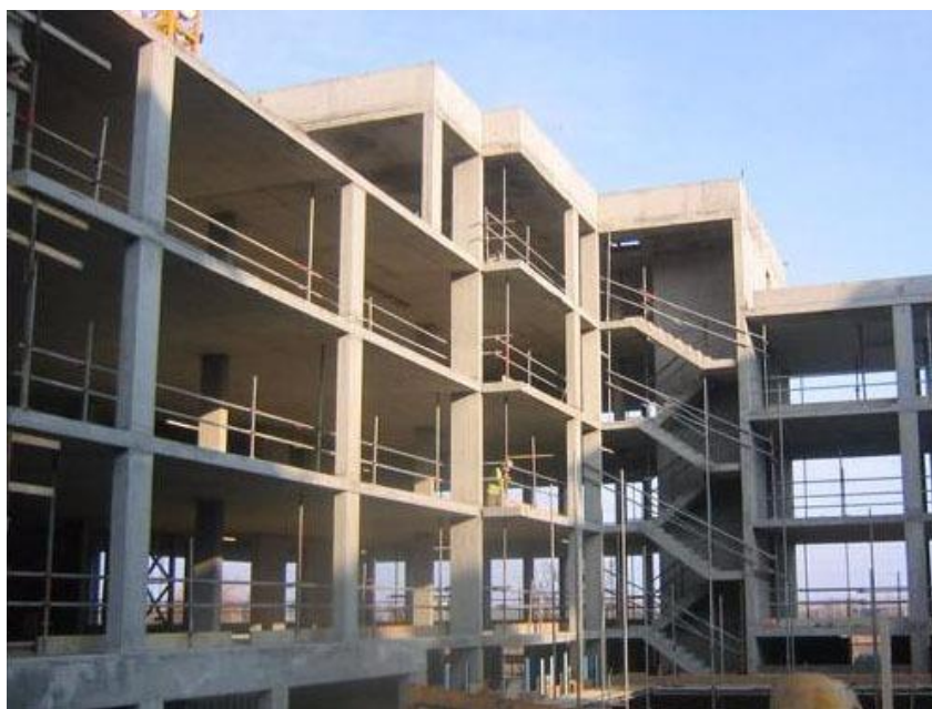
Рис. 2.2 Каркасный монолитный железобетон
