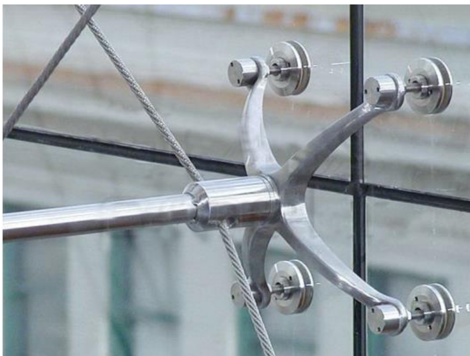
Рис. 2.5 Спайдерная система остекления
