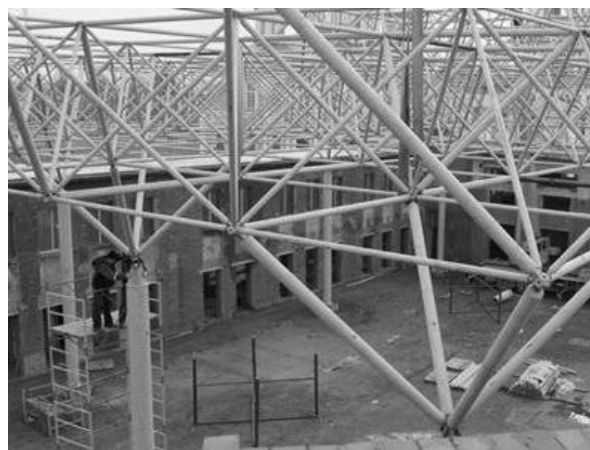
Рис. 21 – Опираение пространственных стержневых конструкций
