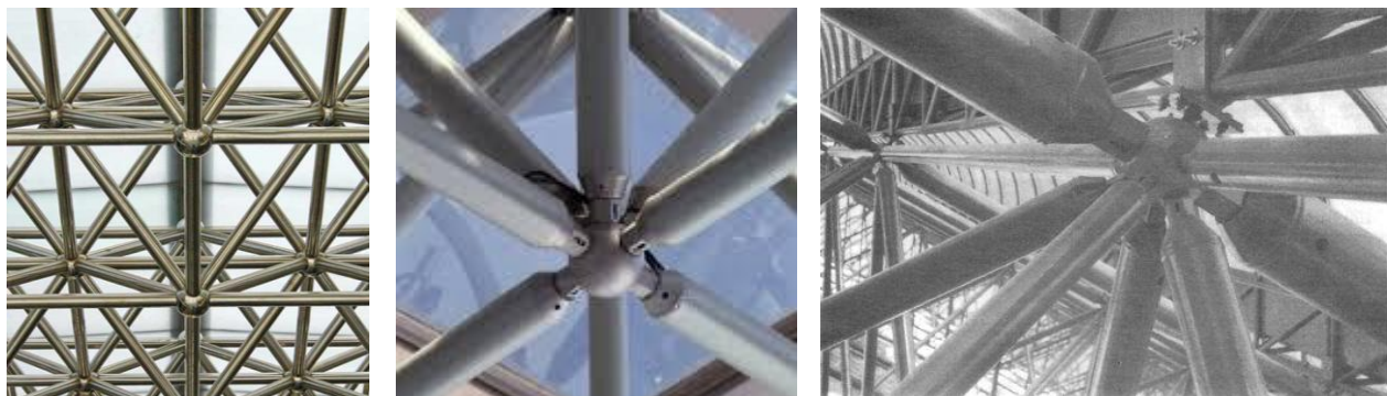
Рис. 19 – Узлы пространственных стержневых конструкций
