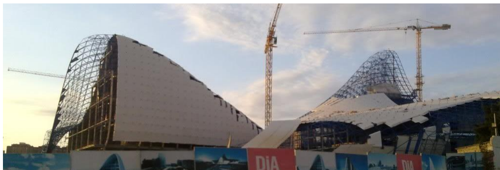
Рисунок 2.8. – Установка фасадных панелей
