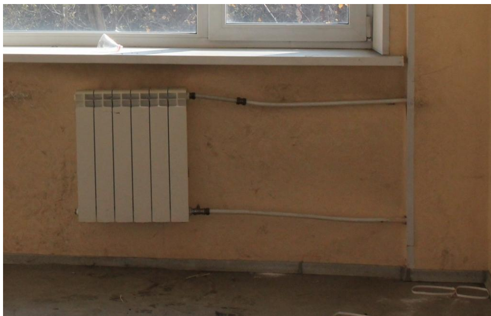
Рисунок 1.4 Подводка из металлополимерных труб
