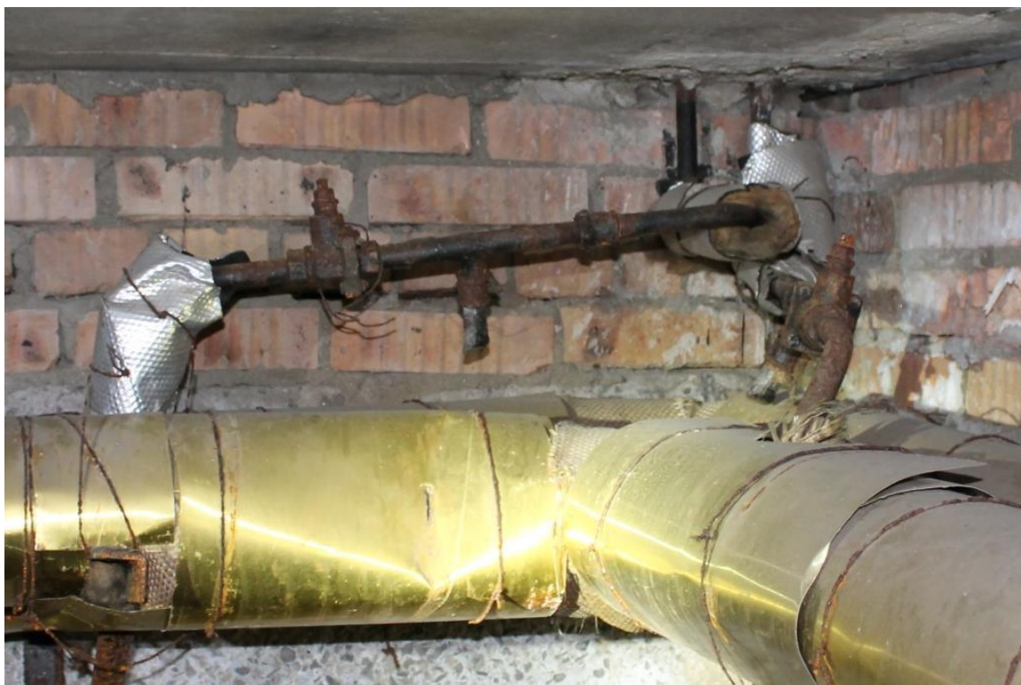
Рисунок 1.6 Подключение стояка системы отопления
