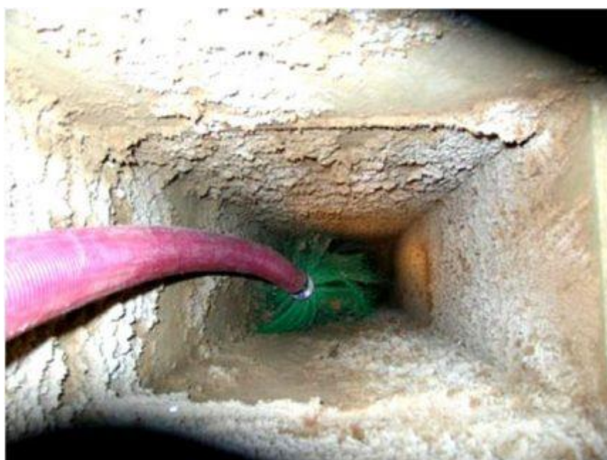
Рисунок 1.21 Очистка вентиляционных каналов от пыли жесткой волосяной щеткой
