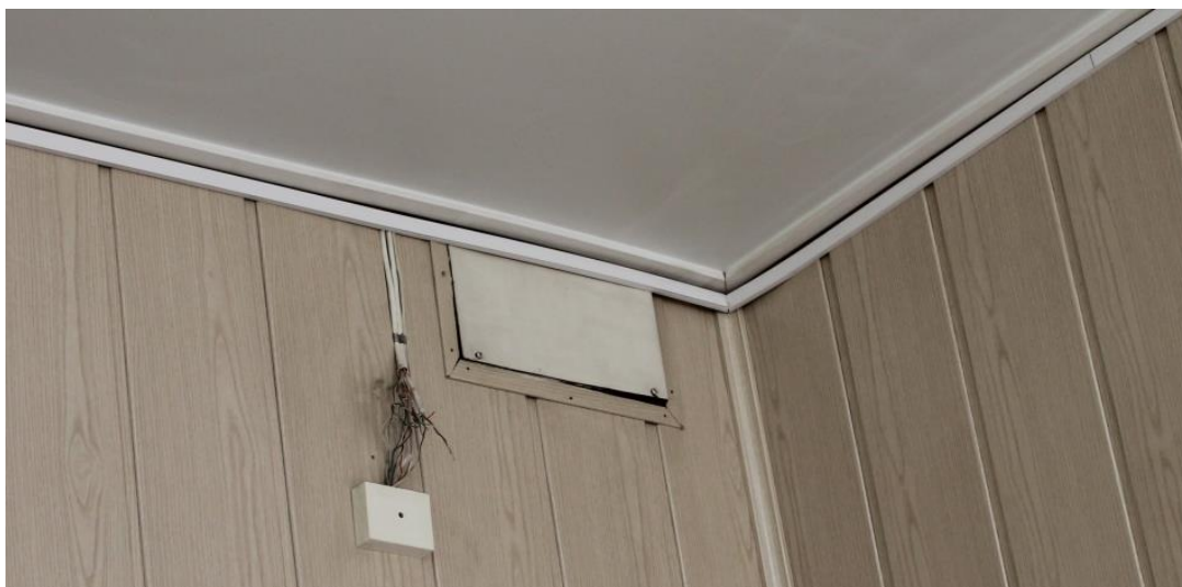
Рисунок 1.10 Замоноличенная вытяжная решетка
