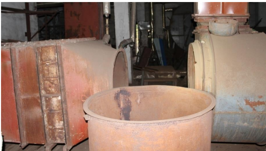
Рисунок 1.14 Вставка между калорифером и вентилятором
