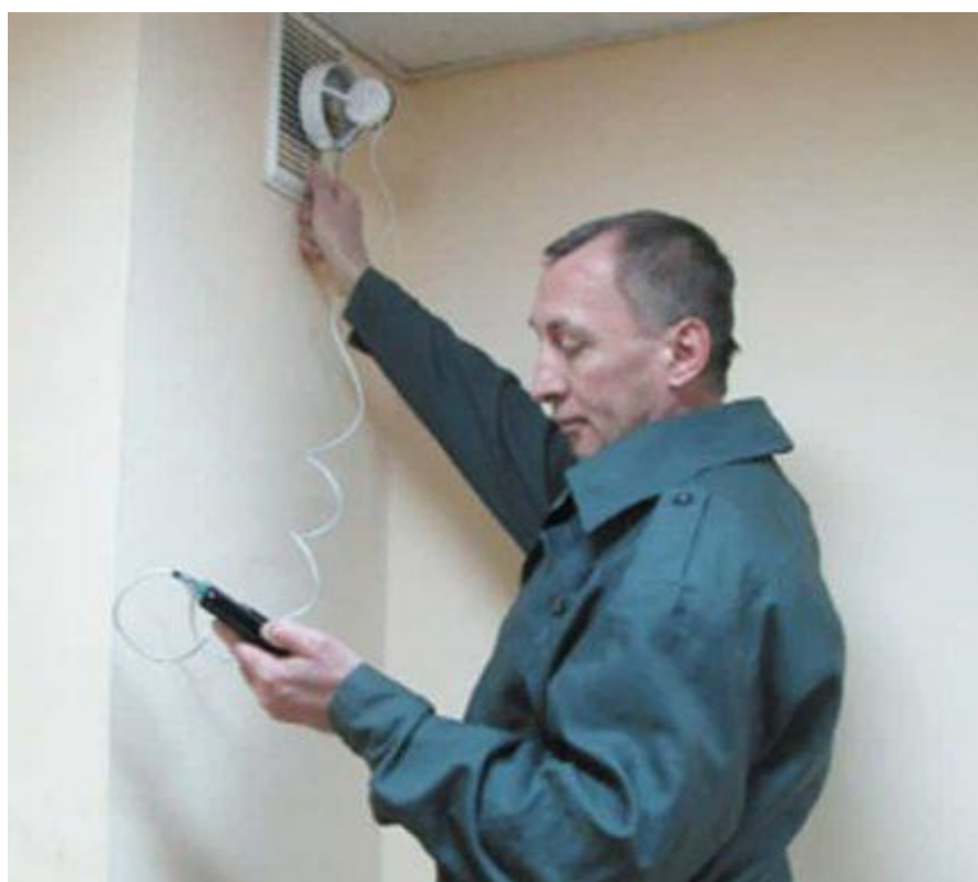
Рисунок 1.20 Проверка тяги в канале анемометром
