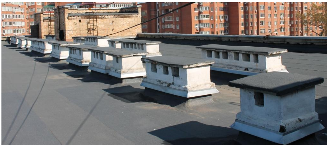
Рисунок 1.8 Вентиляционные шахты
