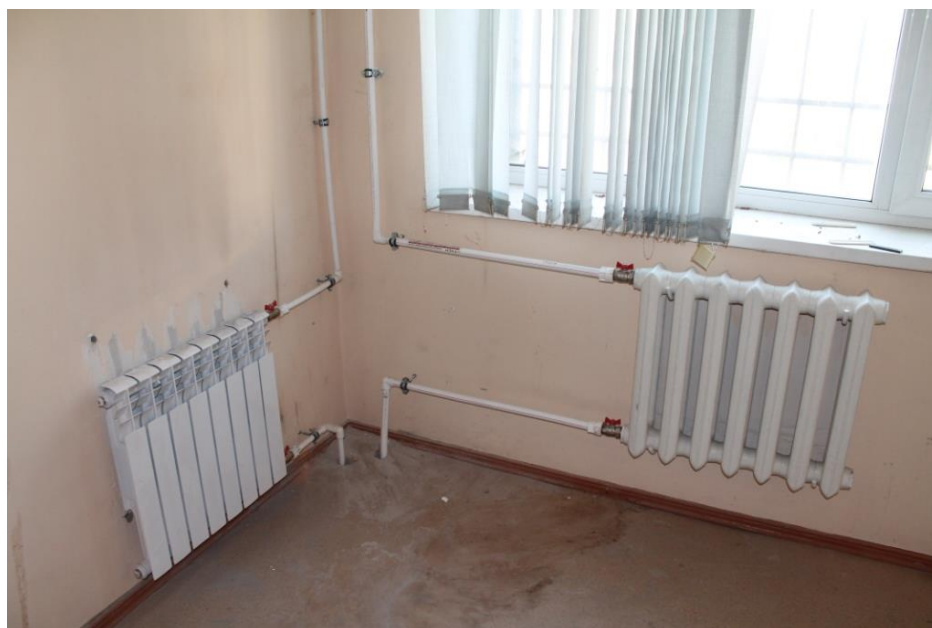
Рисунок 1.3 Алюминиевый и чугунный радиаторы
