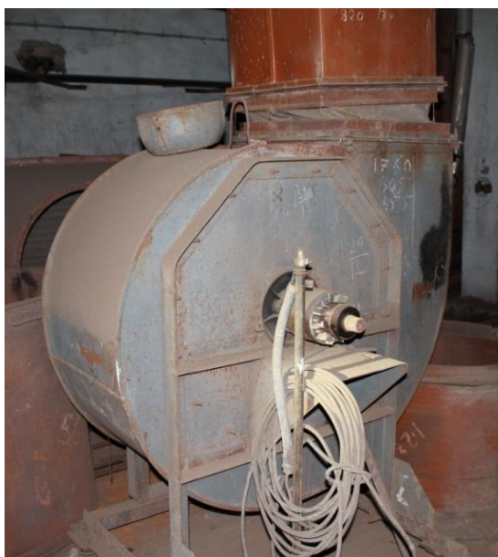
Рисунок 1.13 Приточный вентилятор без электродвигателя
