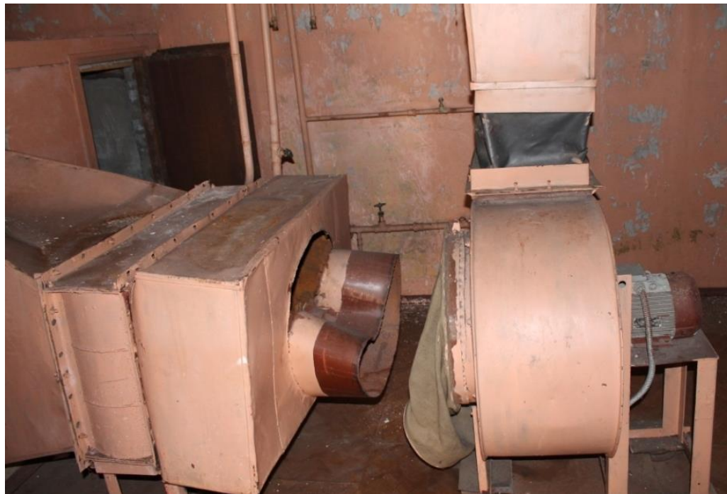
Рисунок 1.15 Приточная вентиляция спортзала
