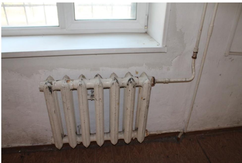
Рисунок 1.1 Чугунный радиатор МС-140
