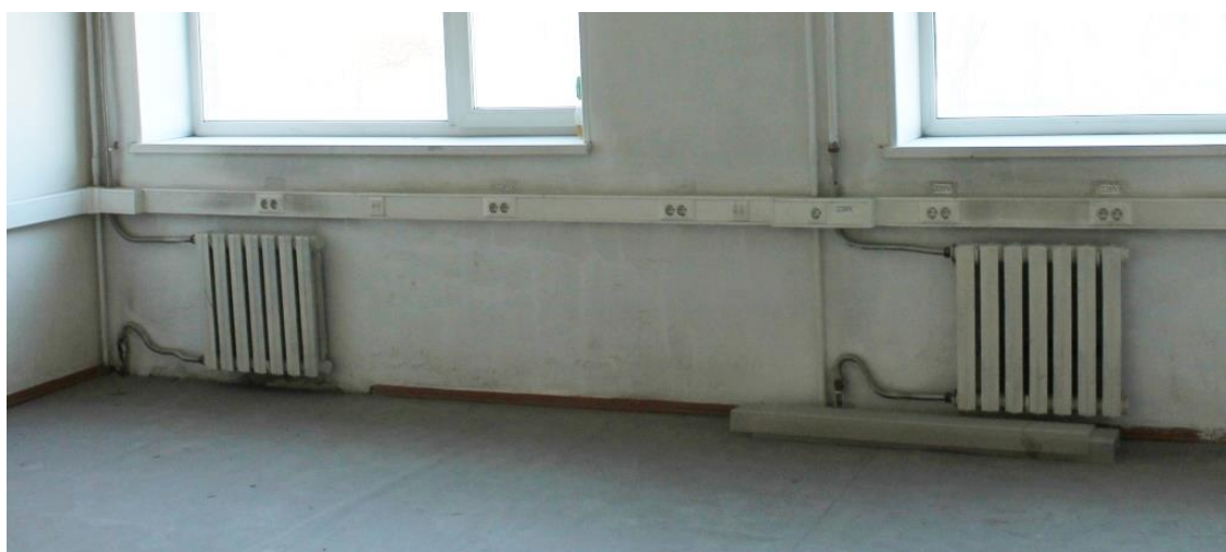
Рисунок 1.5 Подводка из стальных гофрированных труб
