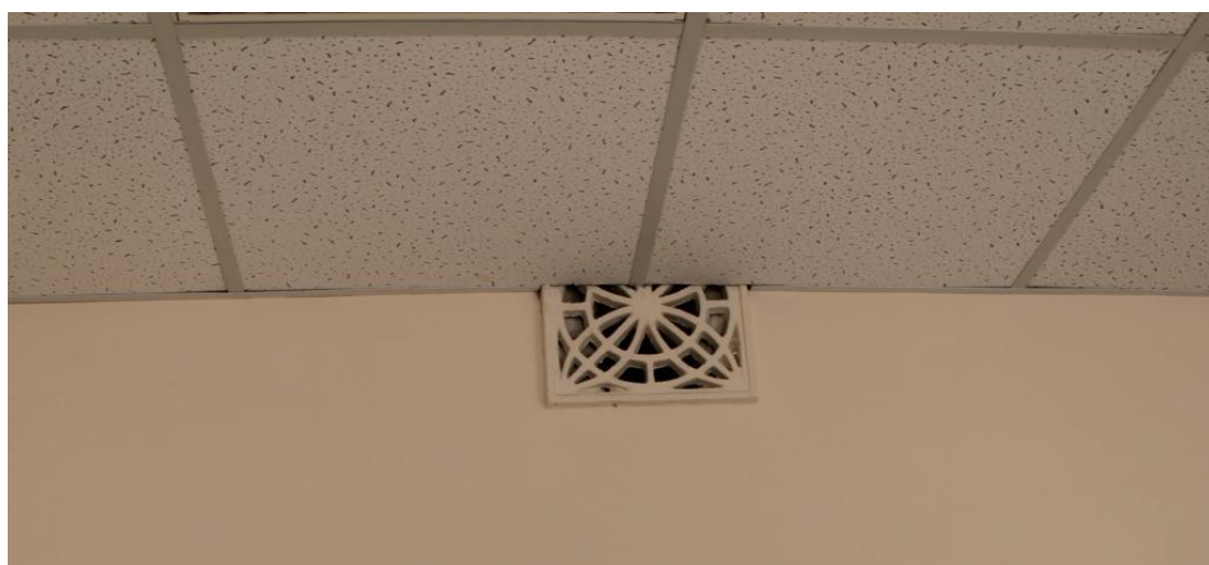
Рисунок 1.9 Частично заблокированная вытяжная решетка
