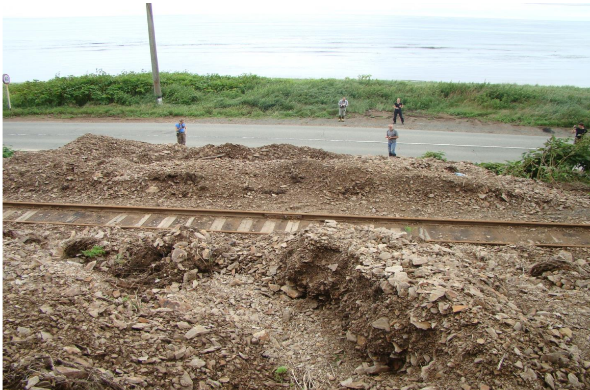
Рис. 3.4 Селевые отложения после схода селевого потока на железнодорожное и автомобильное полотно. Фото Генсировского Ю.В.
