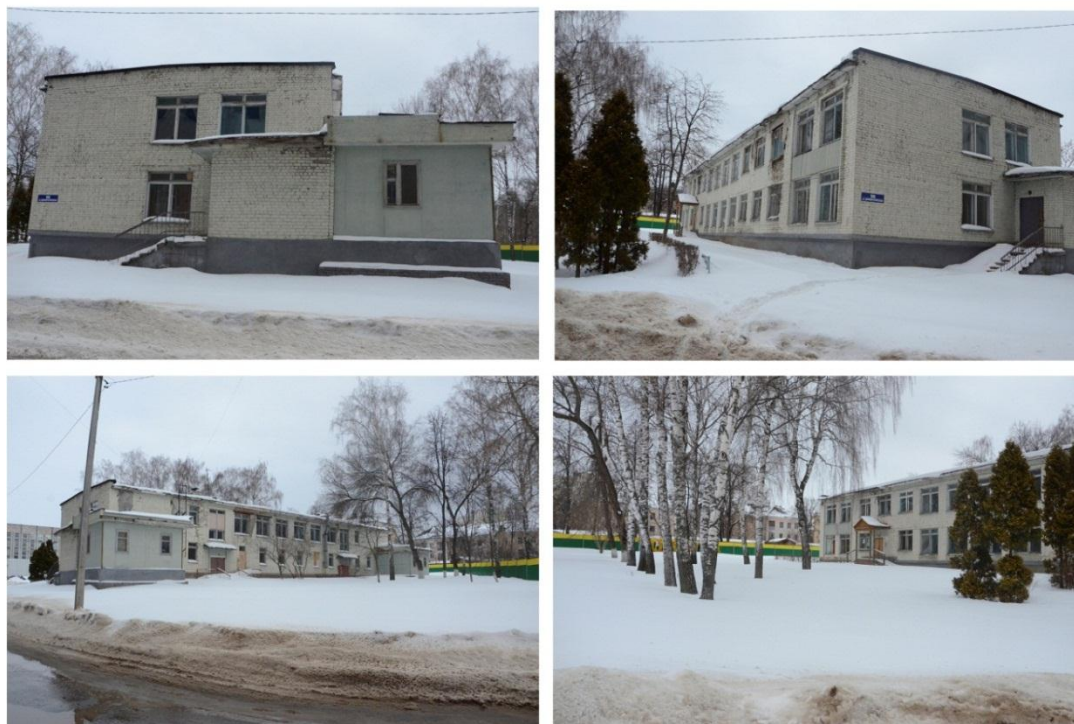
Рисунок 10 — Существующее здание по ул. Демократическая, 100
