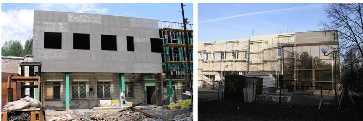
Рисунок 24 – Здание выставочного комплекса СО РАН г.Новосибирск во время реконструкции
