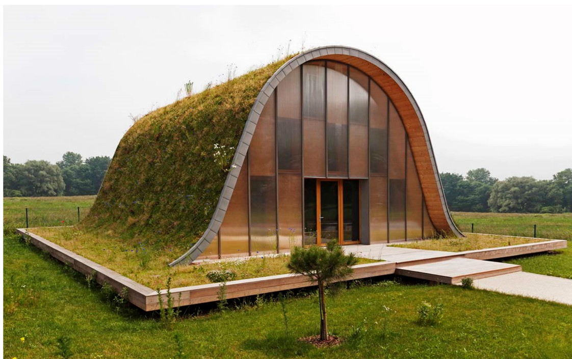
Рисунок 37 – Экстенсивная зеленая кровля на наклонной поверхности
