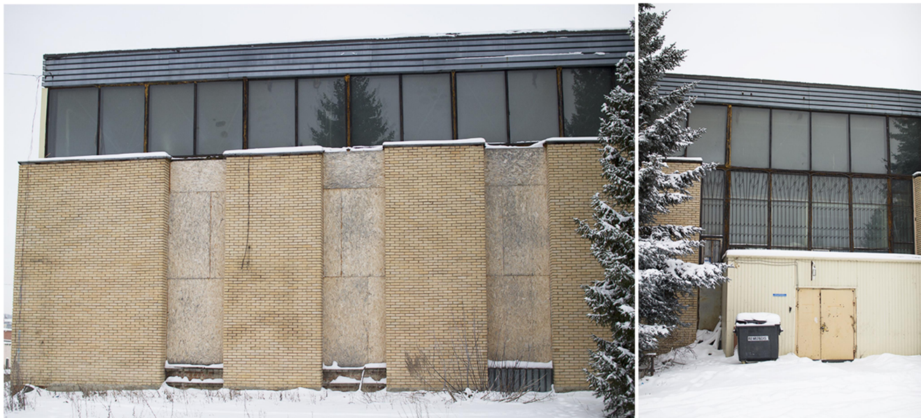
Рисунок 10 – Складское здание. Юго-западный и Юго-восточный фасады
