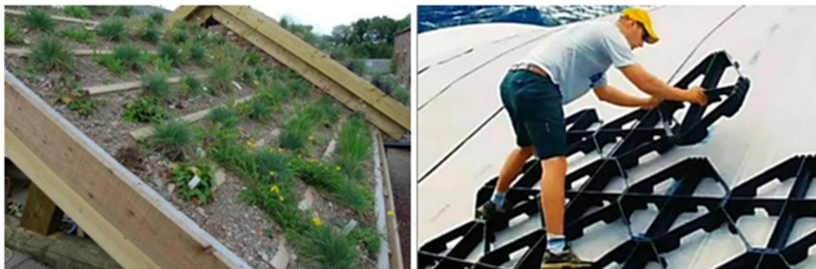
Рисунок 35 – Поперечные фиксаторы, предотвращающие сползание почвы и растительности при устройстве зеленой кровли
