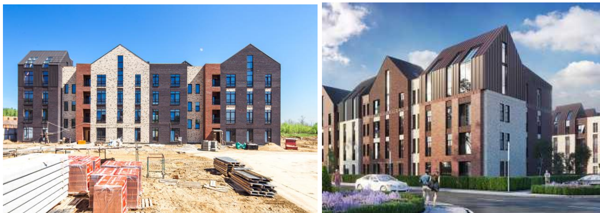
Рисунки 22, 23 – ЖК «Парк Апрель» Апрелевка, Подмосковье, арх. бюро UNK project, 2018-2021 гг.
