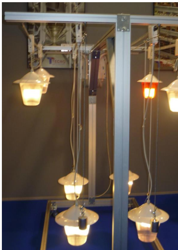
Рисунок 3.3 – Подвес светильников на тросах
