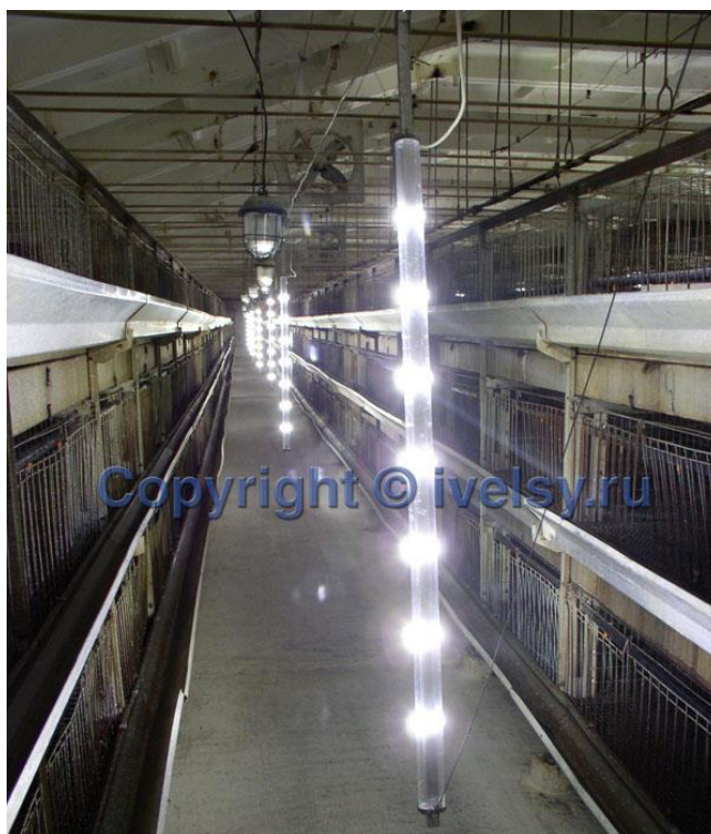
Рисунок 3.13 – Подвеска линий освещения
