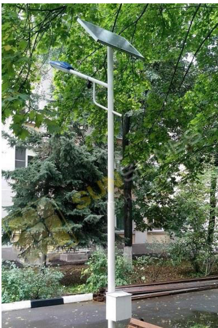
Рисунок 2.1 – Автономный уличный светильник
