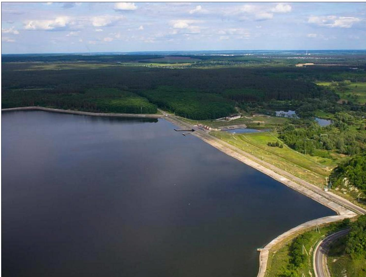
Рис.1. Плотина Белгородского водохранилища
