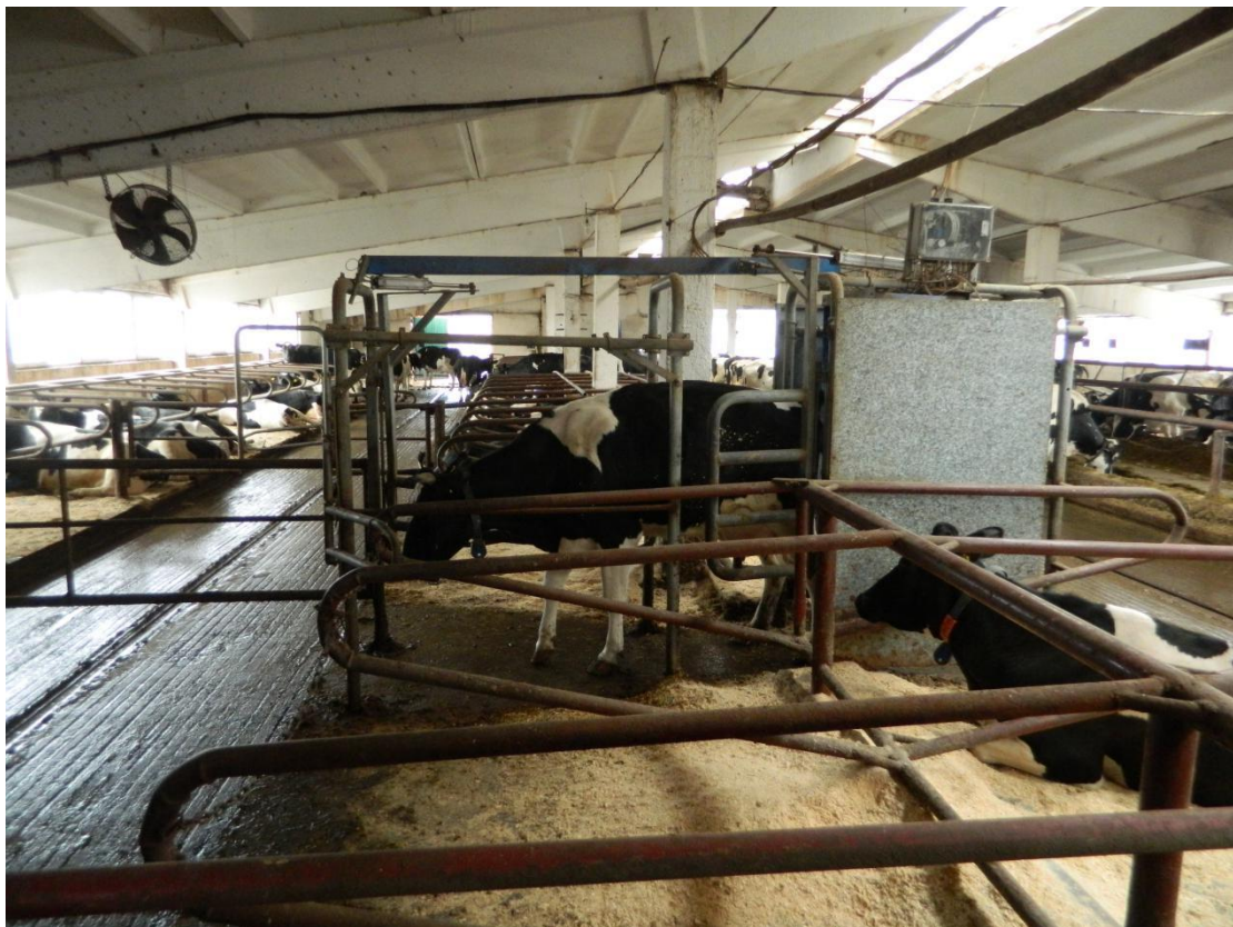
Рис. 49. Рамка для считывания транспондера у коровы.
