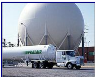
Рисунок 12. Крупный криогенный азотный резервуар
