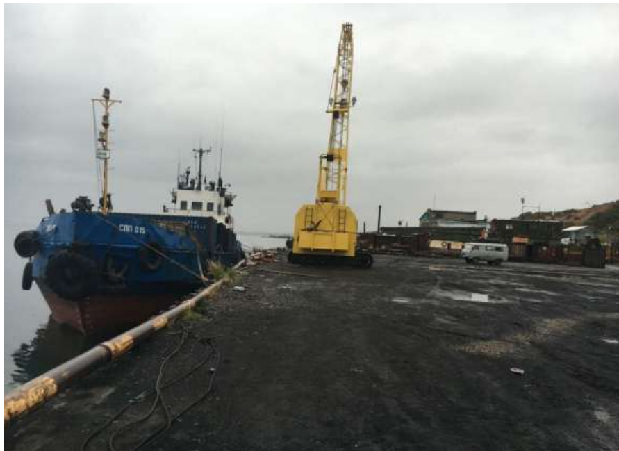
Рисунок 3. Современное состояние портового пункта Тилички
