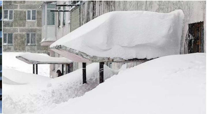
Рисунок 1.4.2 – Снегозаносы входных групп АЗРФ
