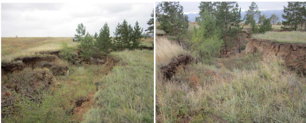
Рисунок 6 – Овражная эрозия на участке «Гусиноозерский» [26]
