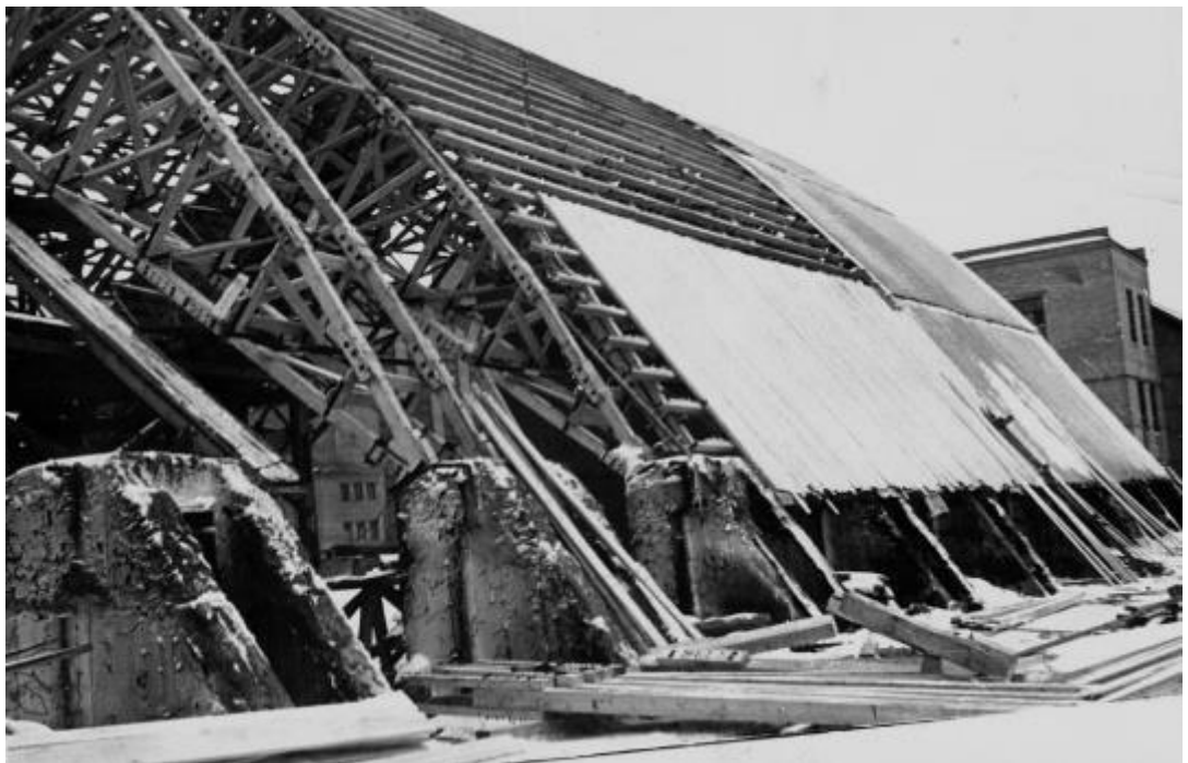
Рисунок 2.3 – Общий вид каркаса склада
