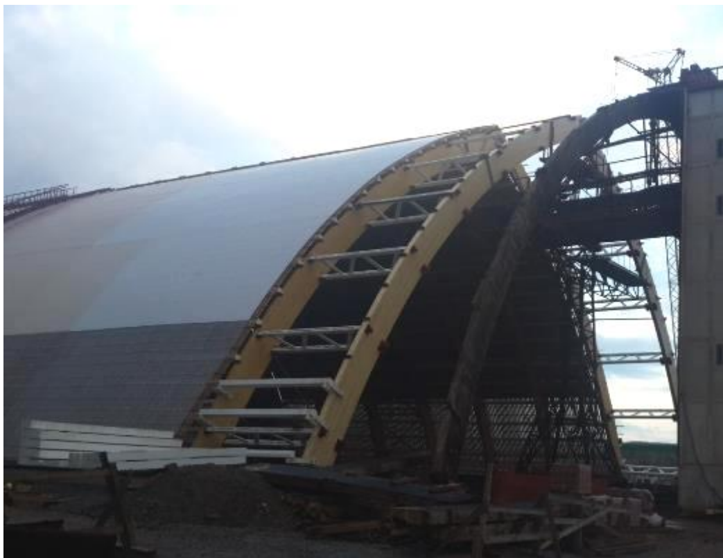
Рисунок 2.1 – Стрельчатый склад пролетом 45 метров
