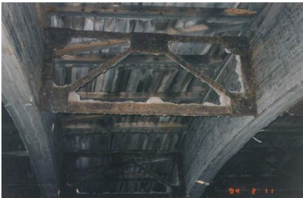
Рисунок 2.5 – Связевая ферма на складе руды
