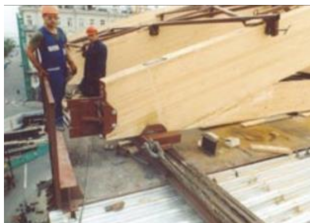
Рисунок 1.17 – Монтаж деревянных конструкций на клеенных стержнях
