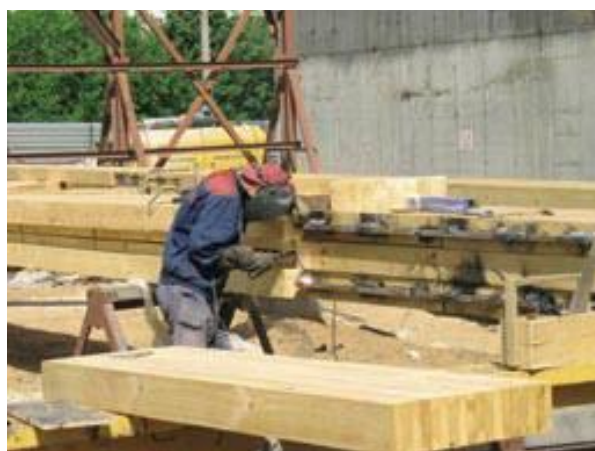
Рисунок 1.17 – Монтаж деревянных конструкций на клеенных стержнях
