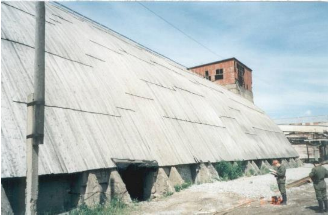
Рисунок 2.2 – Общий вид склада системы Деревягина
