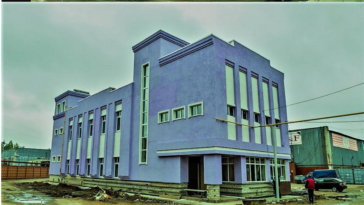
Офисное здание «ДОНАТО»
