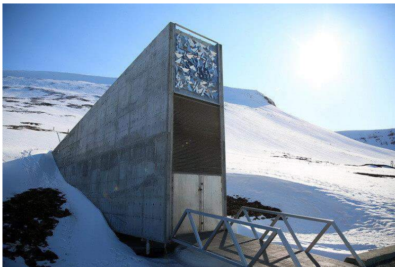
Рисунок 17- Вход в Свалбардский Глобальный Банк Семенных Фондов (источник [28])
