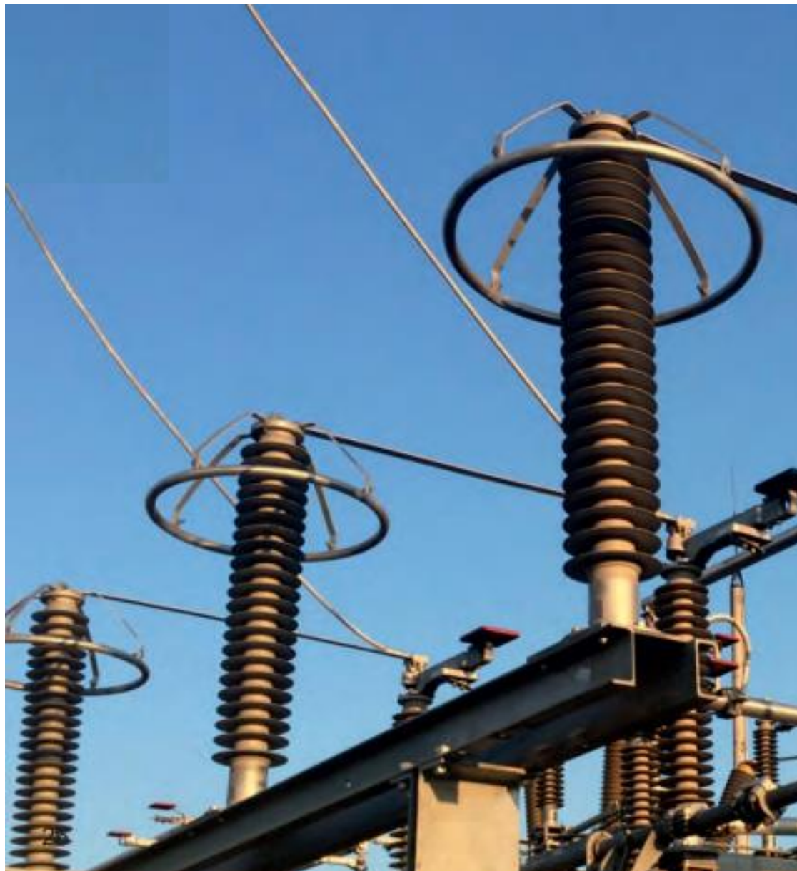
Рисунок 7.10 – ОПН 110 кВ производства «ЗЭТО»
