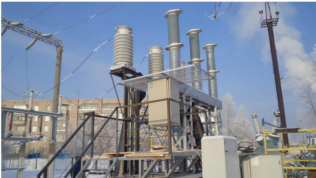
Рисунок 7.6 – Выключатель ВРС-110 с встроенным трансформатором тока типа ТФЗМ
