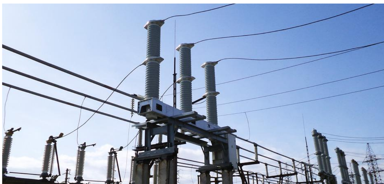
Рисунок 7.2 – Выключатель ВРС-110
