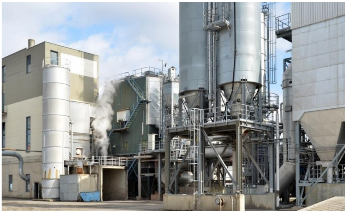
Рисунок 1.2 – Электростанция «Bio- und Holzkraftwerk Zapfendorf»
