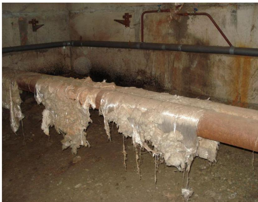
Рис.1.3. Нарушение теплоизоляции трубопровода
