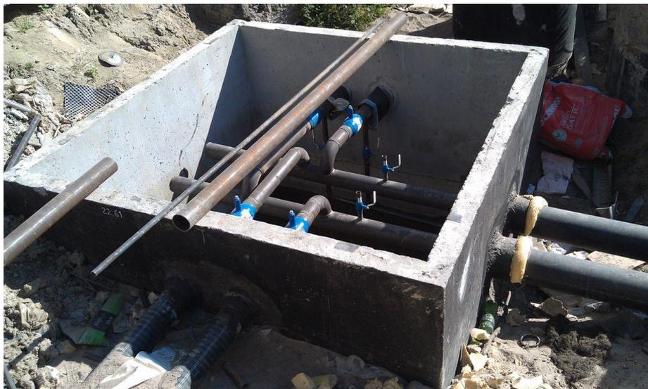
Рис.3.1. Тепловая камера
