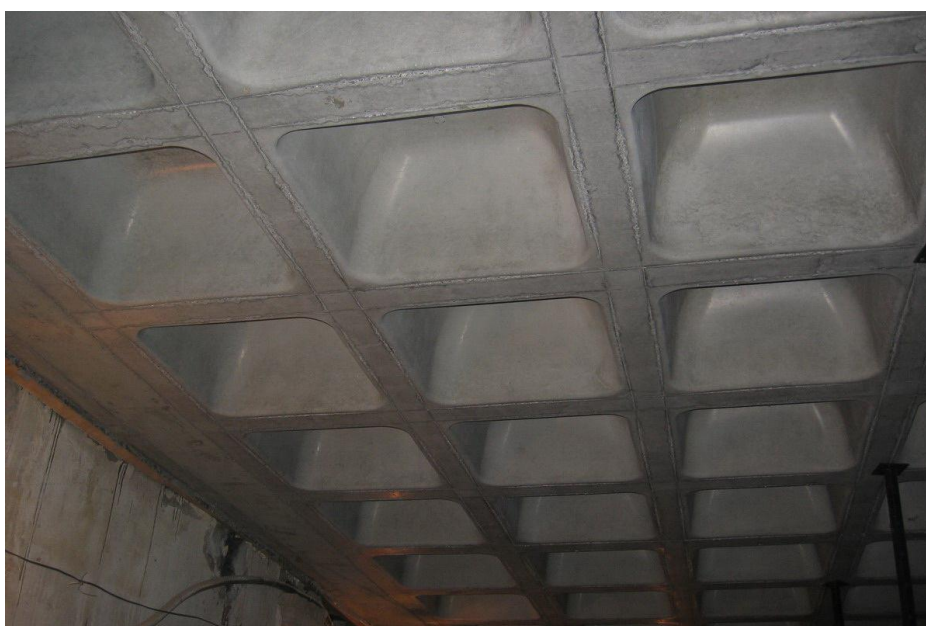
Рисунок 6 - Сплошной монолитный участок у стены
