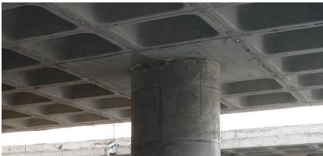
Рисунок 7 - Сплошной монолитный участок у колонны
