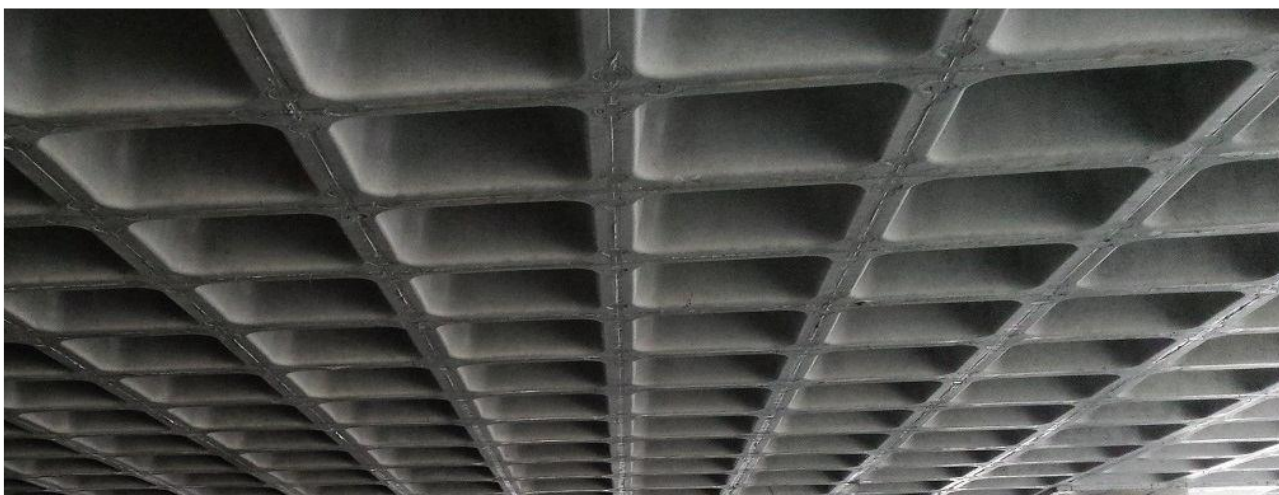
Рисунок 2 - Внешний вид облегченного безбалочного перекрытия
