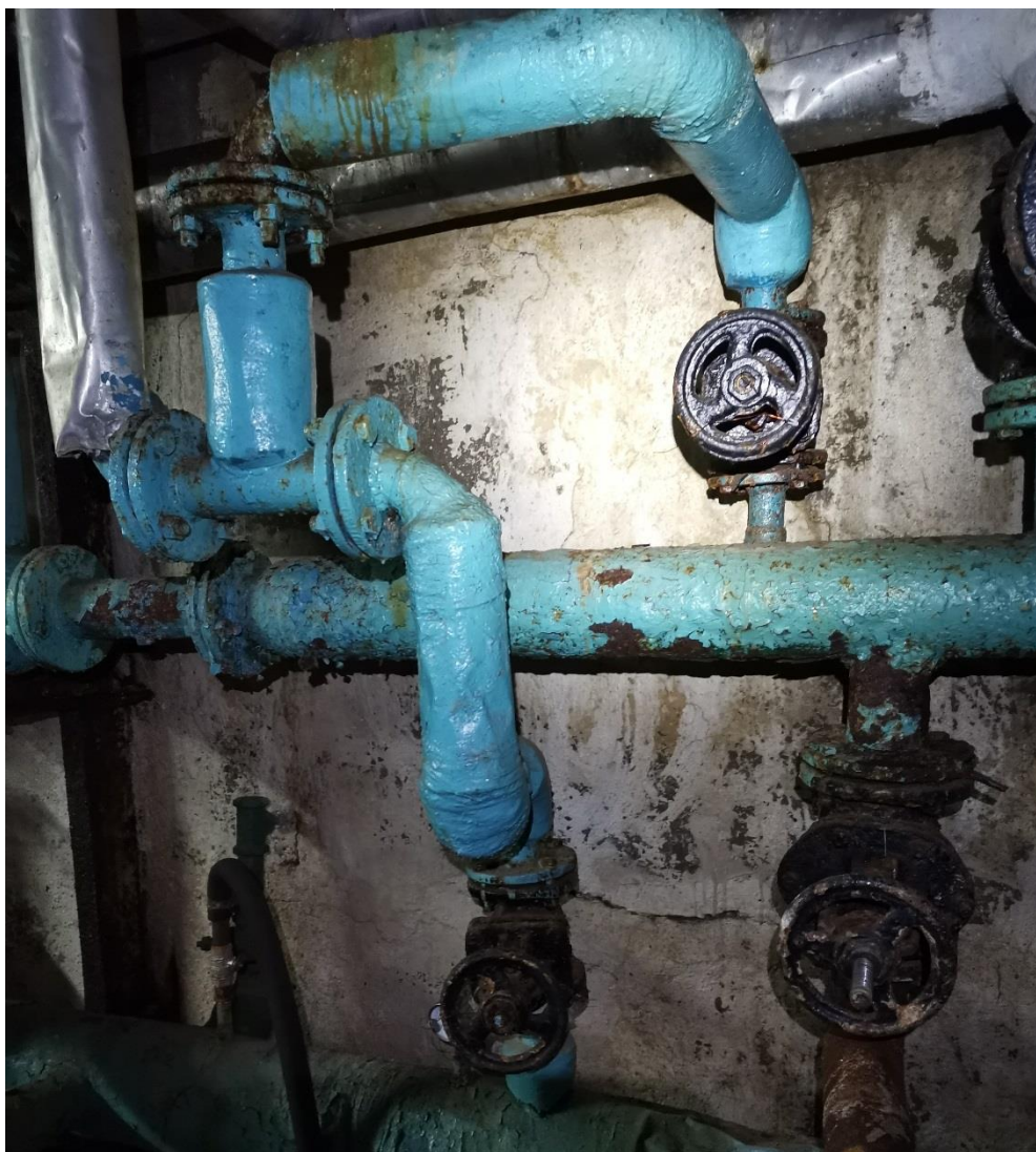
Рисунок 1.8 – Запорная арматура
