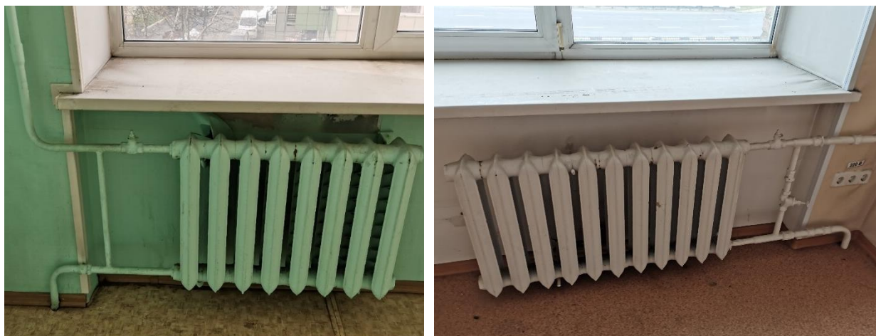
Рисунок 1.2 – Общий вид отопительных приборов (чугунный секционный радиатор)
