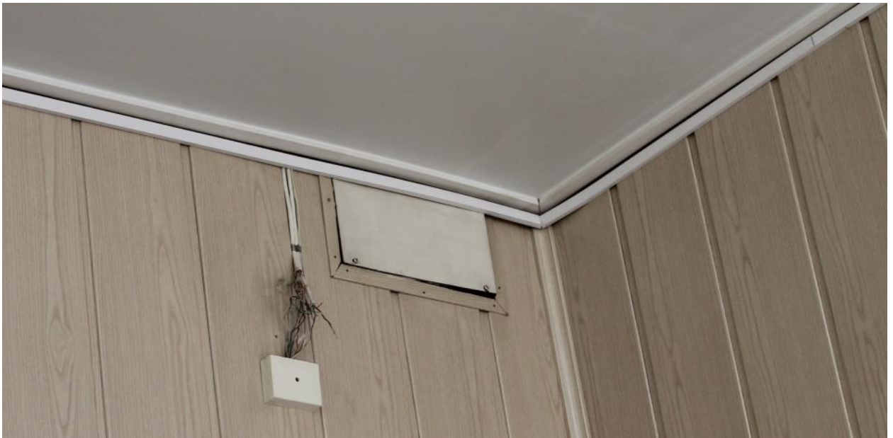
Рисунок 1.4 - Заблокированная вытяжная решетка
