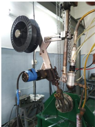
Рисунок 3 - Смонтированное сварочное приспособление
