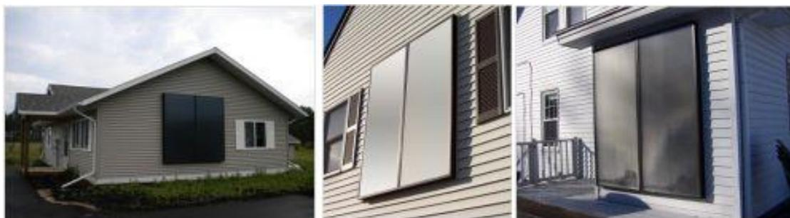
Рис. 1.8 СВК типа «солнечная стена» на фасадах общественных и производственных зданий в Канаде и США [27]
