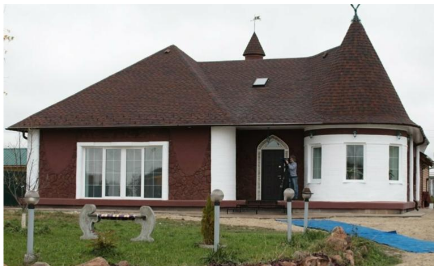
Рисунок 1.4 – Здание, построенное при помощи 3D-принтера
