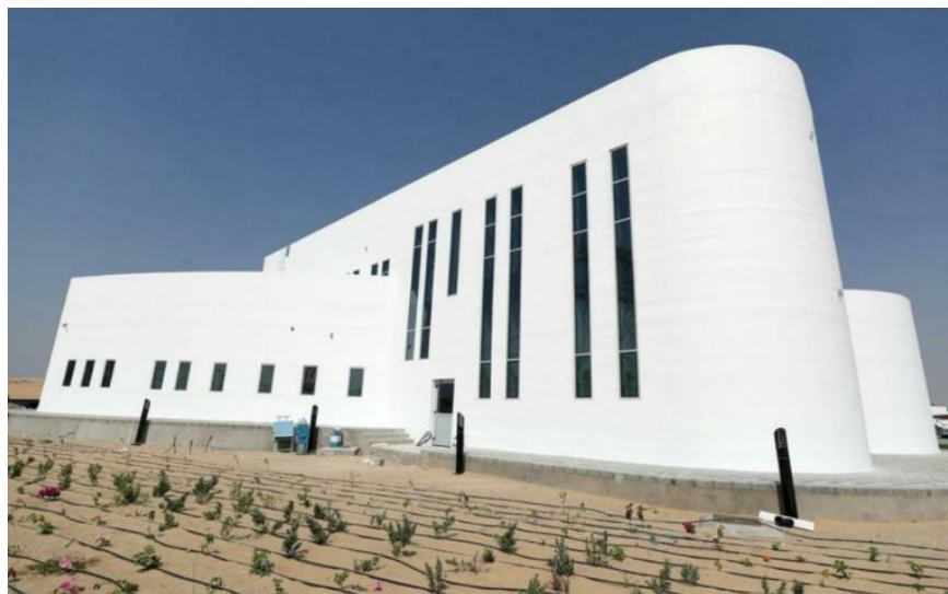
Рисунок 1.6 – Здание, построенное при помощи 3D-принтера
