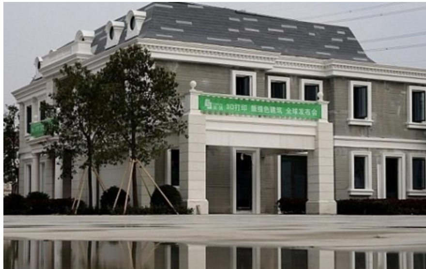
Рисунок 1.1 - Здание, построенное при помощи 3D-принтера
