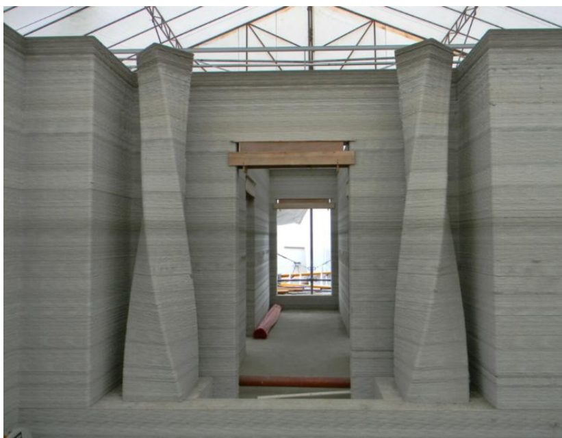
Рисунок 1.2 - Здание, построенное при помощи 3D-принтера
