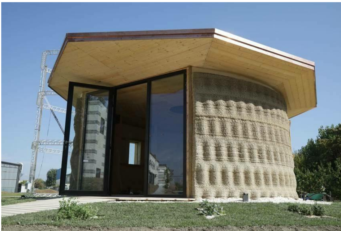
Рисунок 1.5 – Здание, построенное при помощи 3D-принтера
