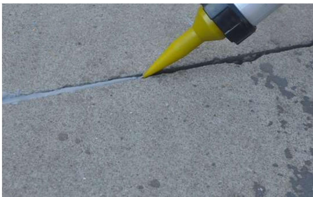
Рисунок 9 – заливка герметика
