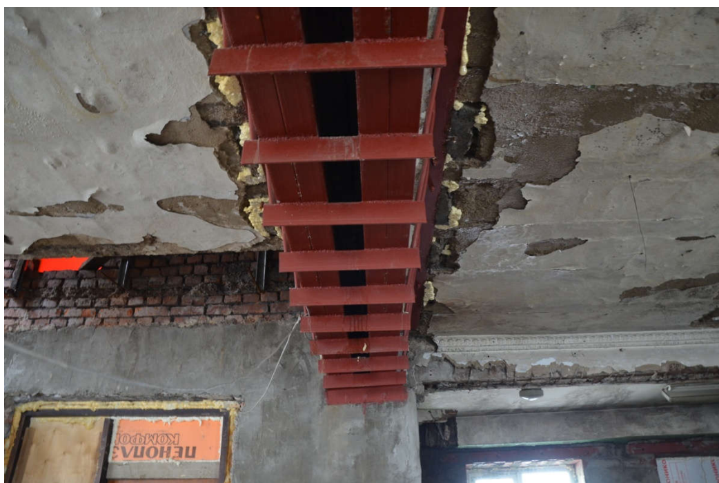
Рисунок 135 – Усиленные балки перекрытий Б-1 на 3 этаже в осях 8-13/Б-Д
