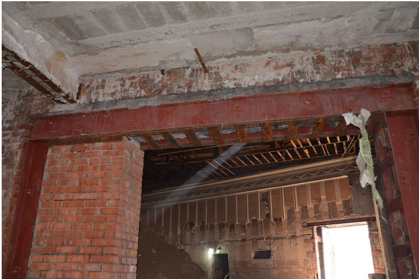
Рисунок 122 - Рама металлическая РМ 2 по оси И
