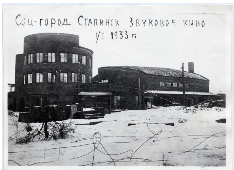
Рисунок 2 - Кинотеатр «Коммунар» в завершающей стадии строительства 1933 г.
