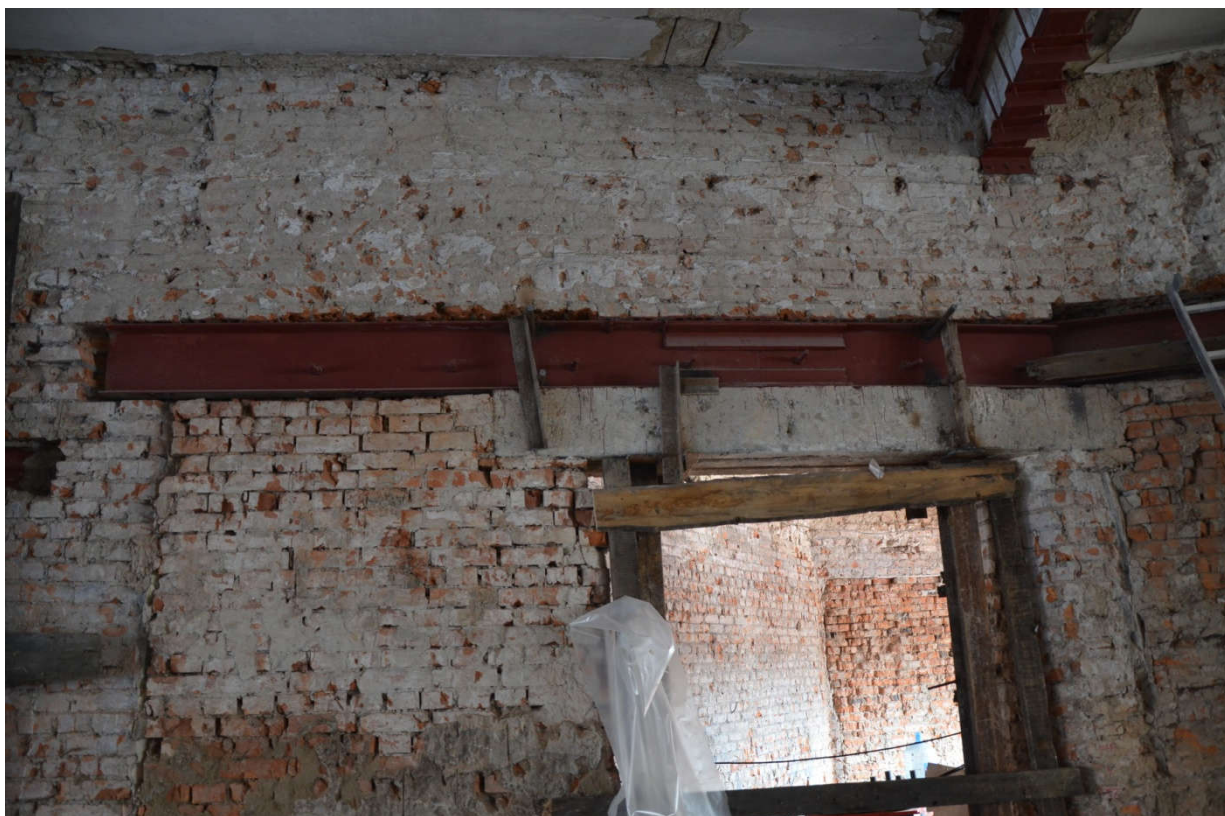
Рисунок 129 – Перемычка 01/4 на 1 этаже по оси Ж
