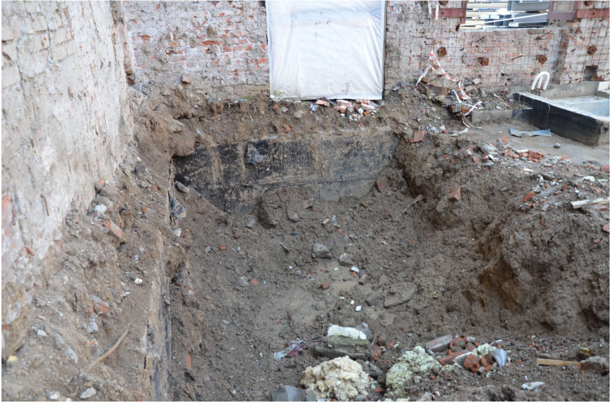
Рисунок 51 – Фундамент Ф18 в осях Д-Г/7
