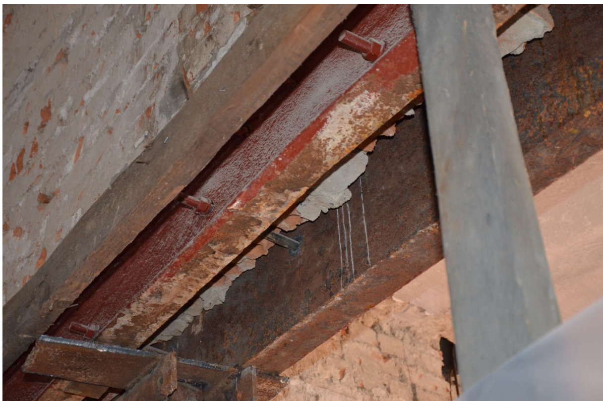
Рисунок 127 – Перемычка 01/2 на 1 этаже по оси Ж
