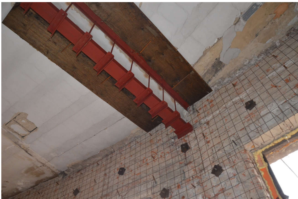
Рисунок 138 – Усиленные балки перекрытий Б-2 на 1 этаже в осях 13-17/Г-Ж
