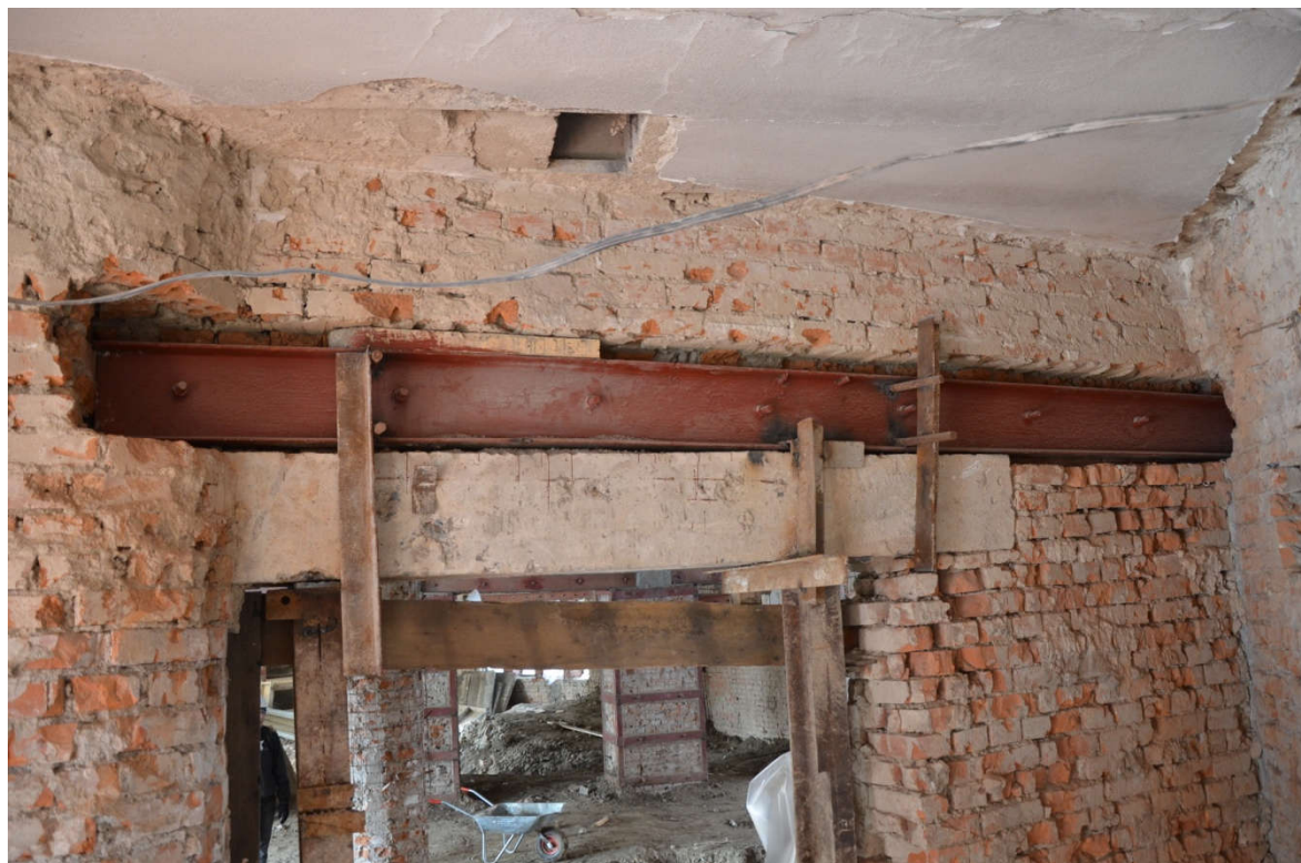
Рисунок 128 – Перемычка 01/3 на 1 этаже по оси Ж
