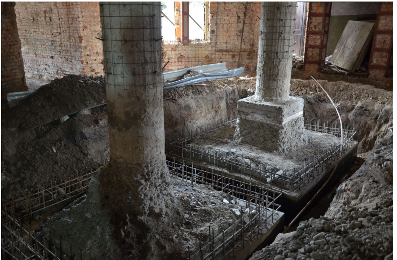
Рисунок 48 – Фундамент Ф6 в осях В-Г/10
