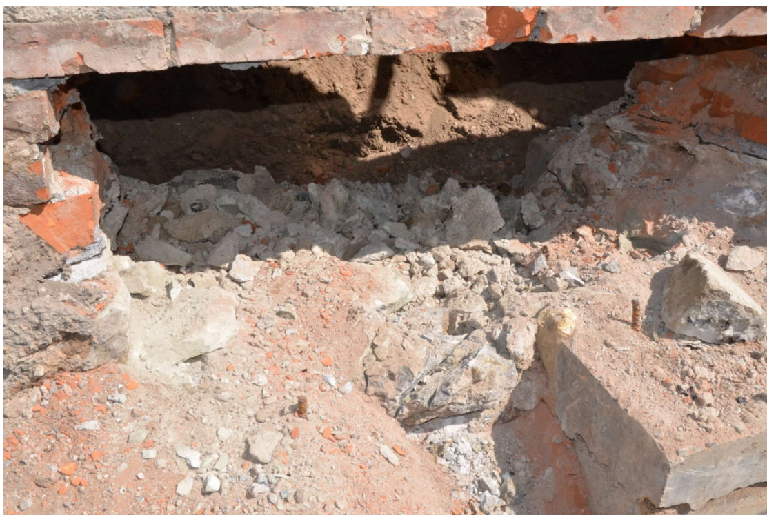
Рисунок 45 – Фундамент Ф8.1 в осях Э-И/14-16
