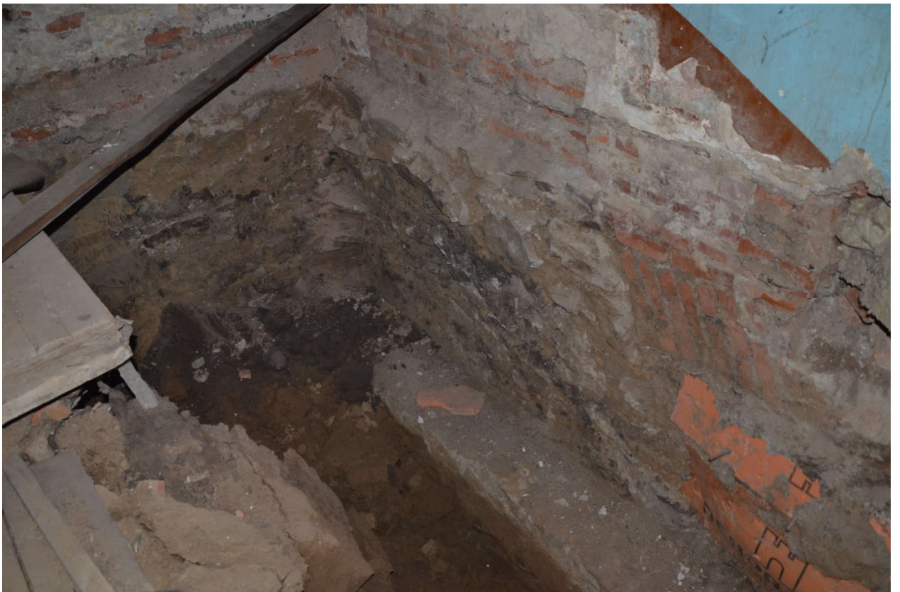
Рисунок 52 – Фундамент Ф2 в осях Д-Г/7-8
