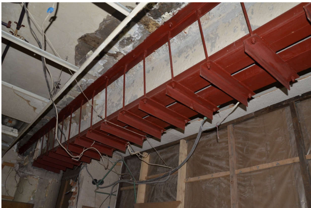
Рисунок 136 – Усиленные балки перекрытий Б-1 на 2 этаже в осях 8-13/Б-Д
