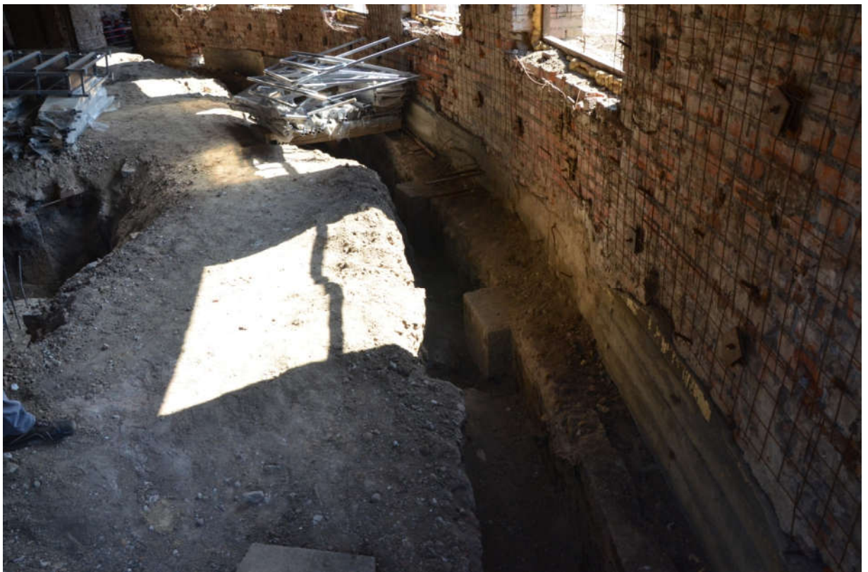
Рисунок 42 – Фундамент Ф1.1 в осях В-Ж/13-17
