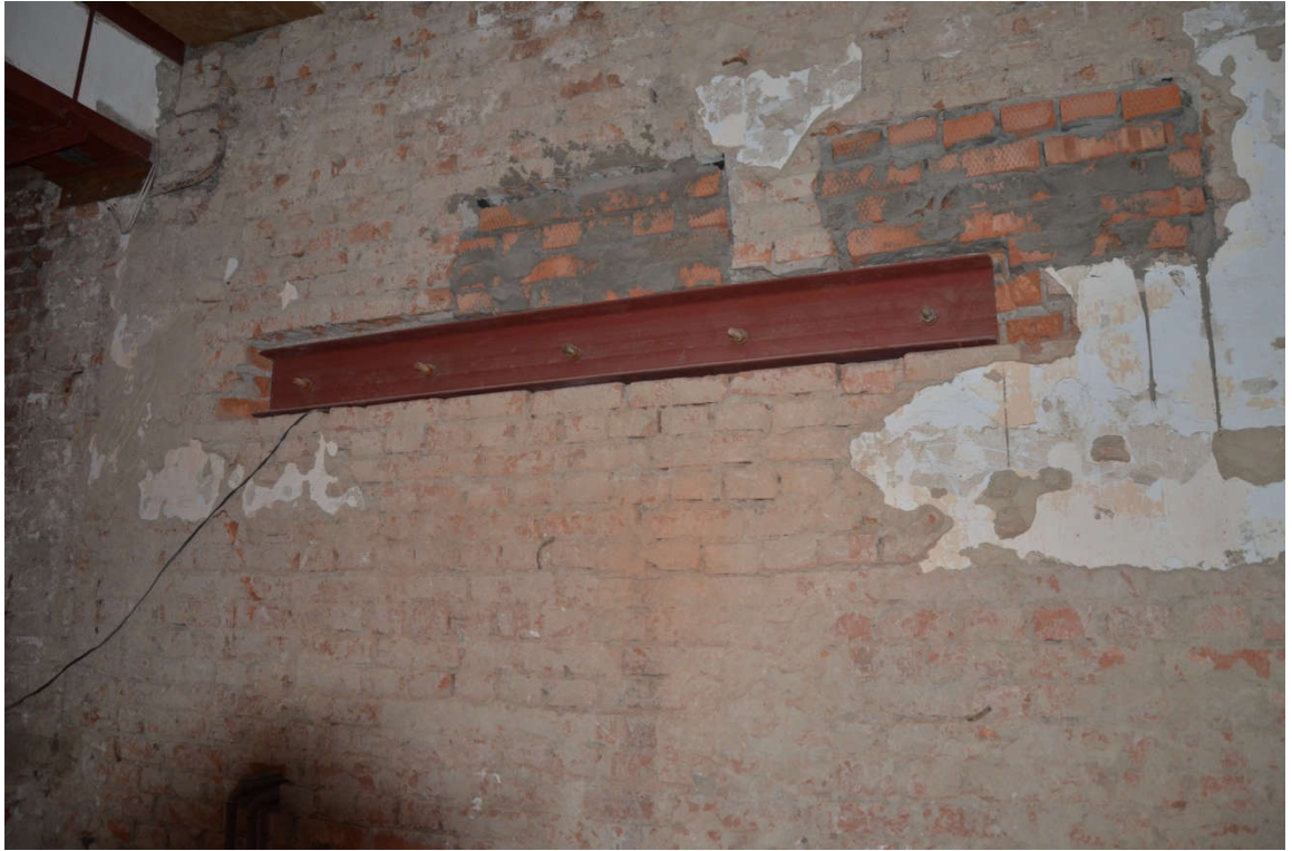
Рисунок 90 - Перемычка 22-1 на 1 этаже по оси 8'
