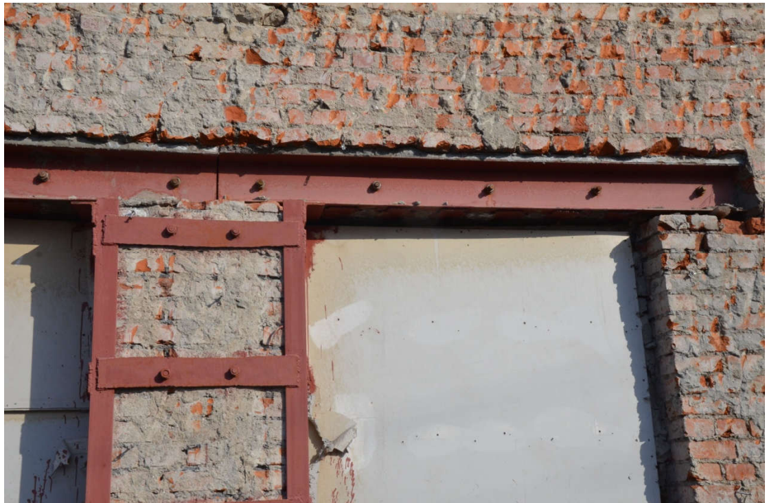
Рисунок 93 – Перемычки 10 на 1 этаже по оси 16
