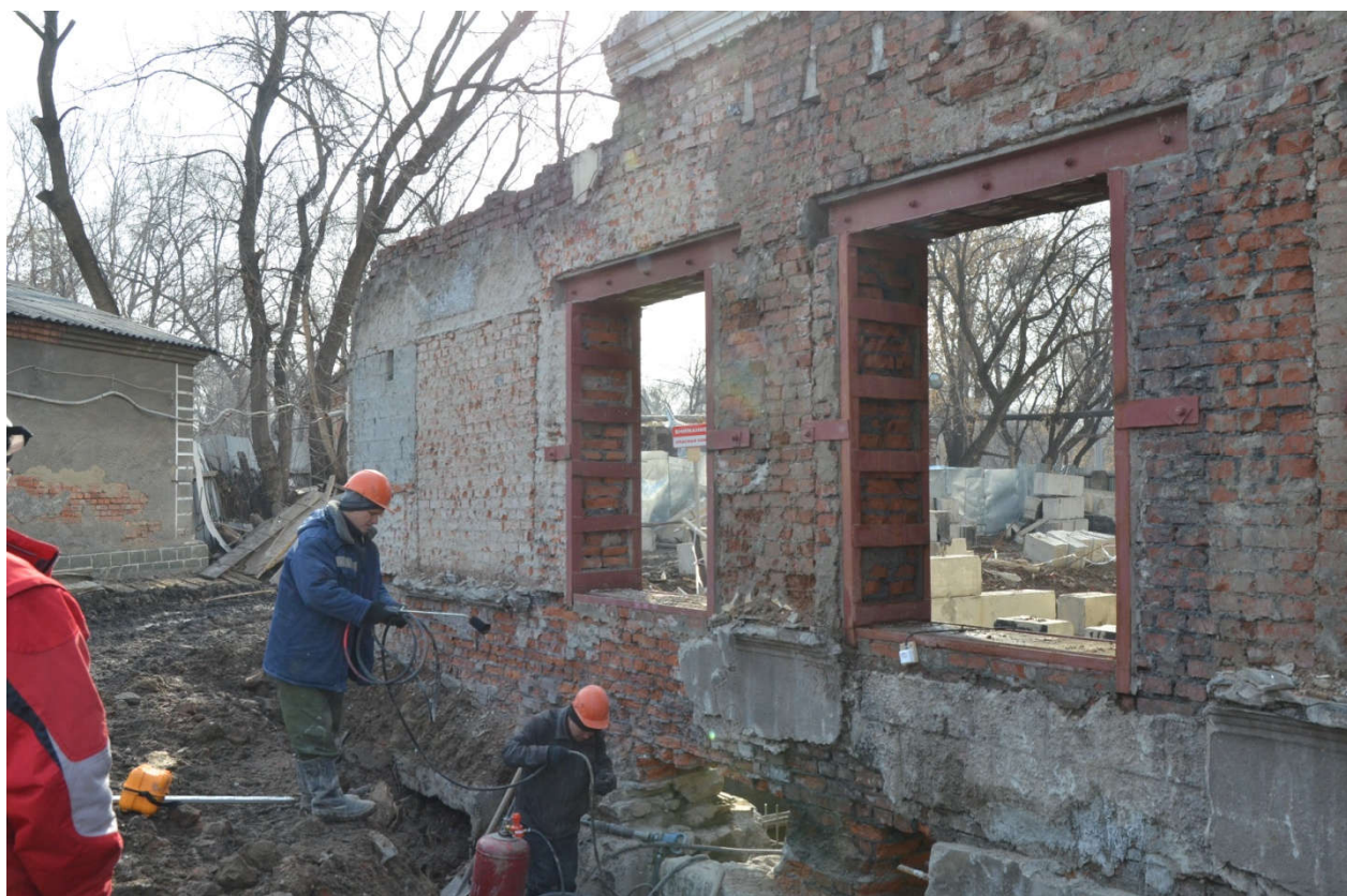
Рисунок 64 – Стена в осях 2/Т-III
