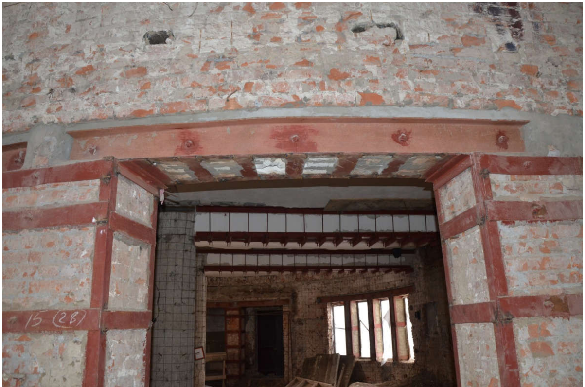
Рисунок 86 - Перемычка 21-1 на 1 этаже по оси Д
