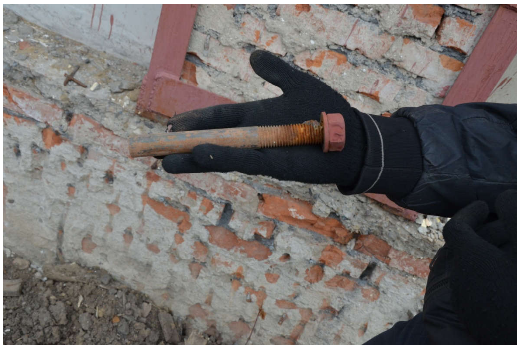
Рисунок 95 – Простенок 10 на 1 этаже по оси 16. Незатянутый болт
