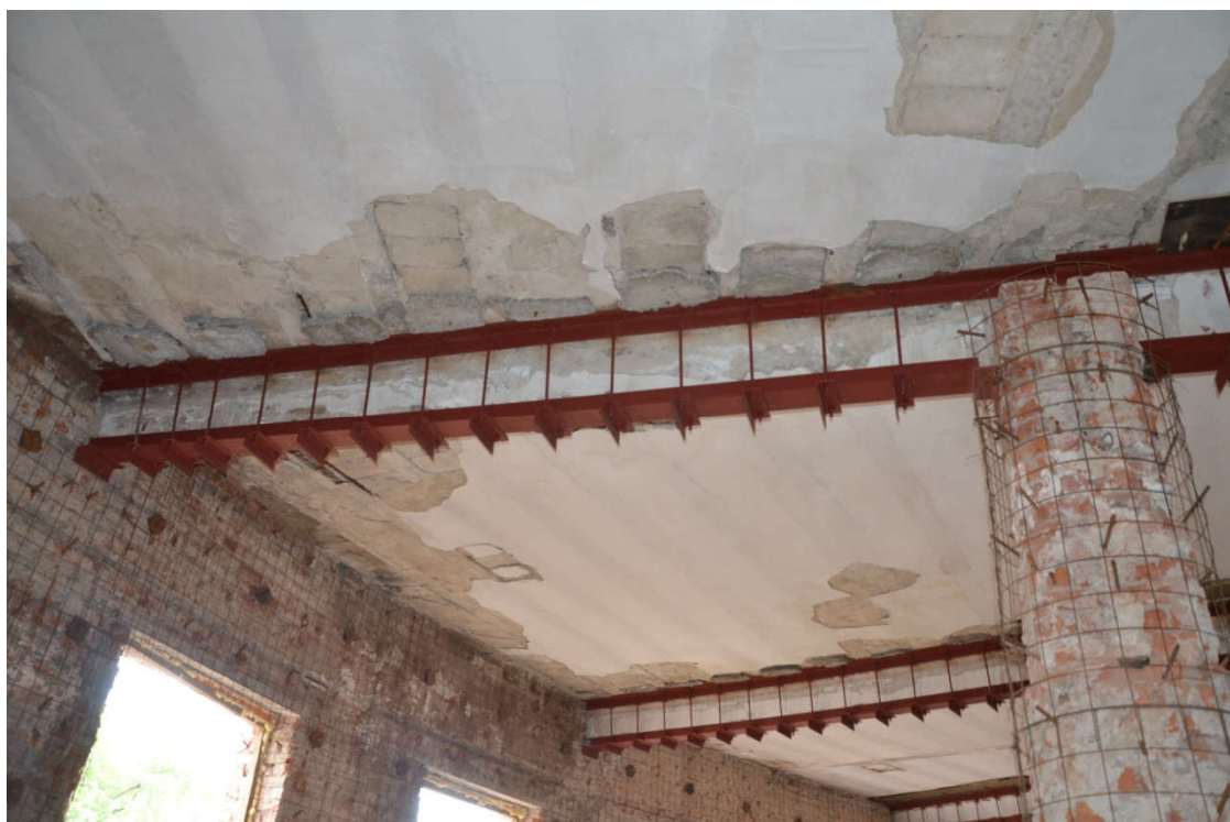
Рисунок 137 – Усиленные балки перекрытий Б-2 на 1 этаже в осях 13-17/Г-Ж
