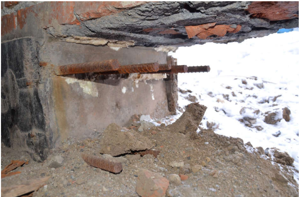
Рисунок 36 – Фундамент Ф 12 в осях Л-Н/1-2. Армирование обвязочной балки выполнено из арматурных стержней \varnothing 22 и \varnothing 16 , что отличается от принятой в рабочей документации ( \varnothing 28 )
