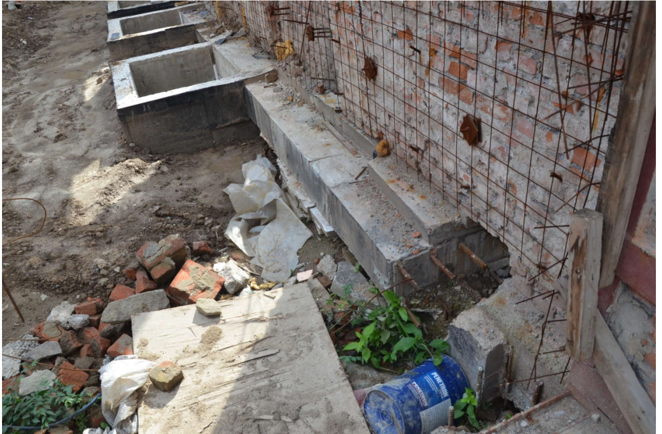
Рисунок 47 – Фундамент Ф1 в осях Г-Ж/1-4. Выполненные прямки для обслуживания сейсмоопор
