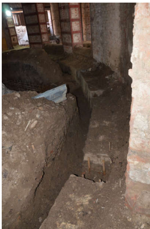
Рисунок 40 – Фундамент Ф16 в осях А-Д/7-13'
