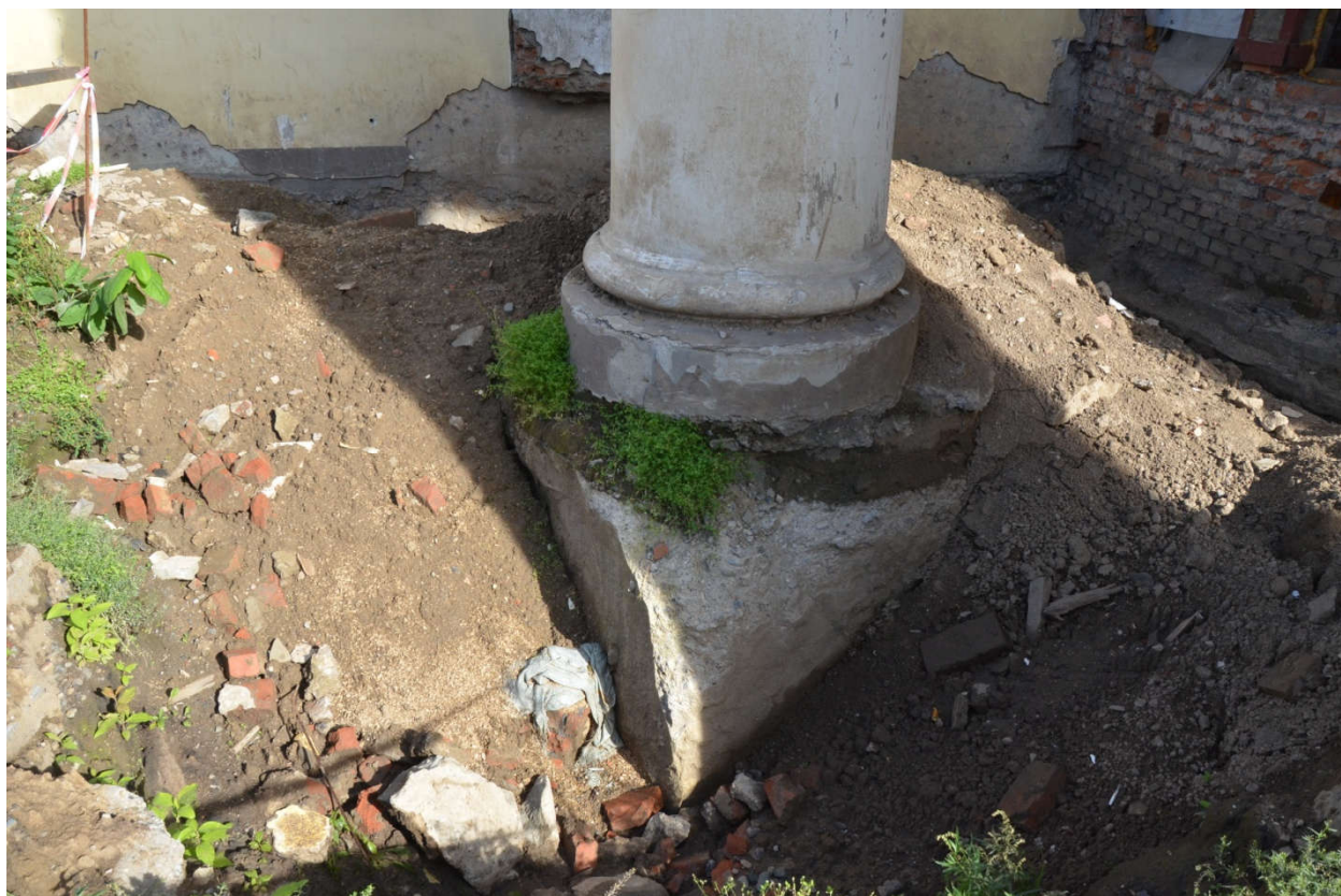
Рисунок 57 – Фундамент Ф4 в осях Б/7-15
