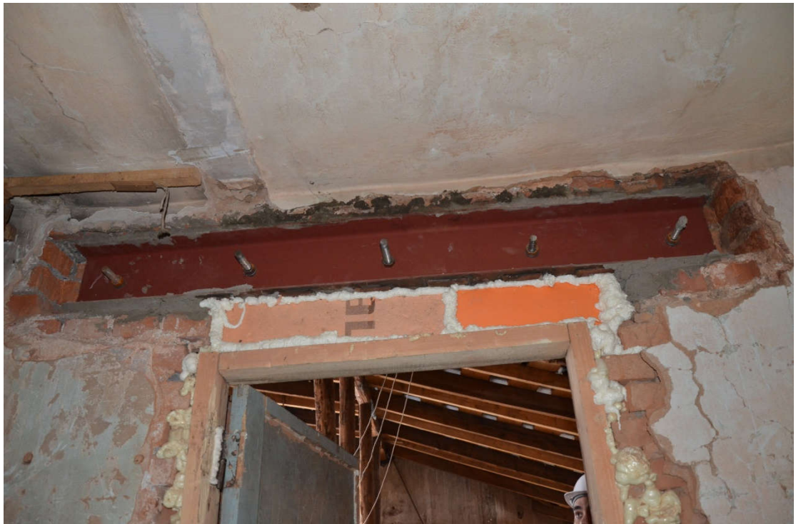
Рисунок 78 - Перемычка 30 на 2 этаже по оси Д
