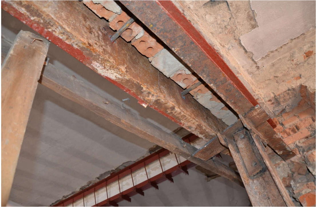
Рисунок 125 – Перемычка 01/1 на 1 этаже по оси Ж
