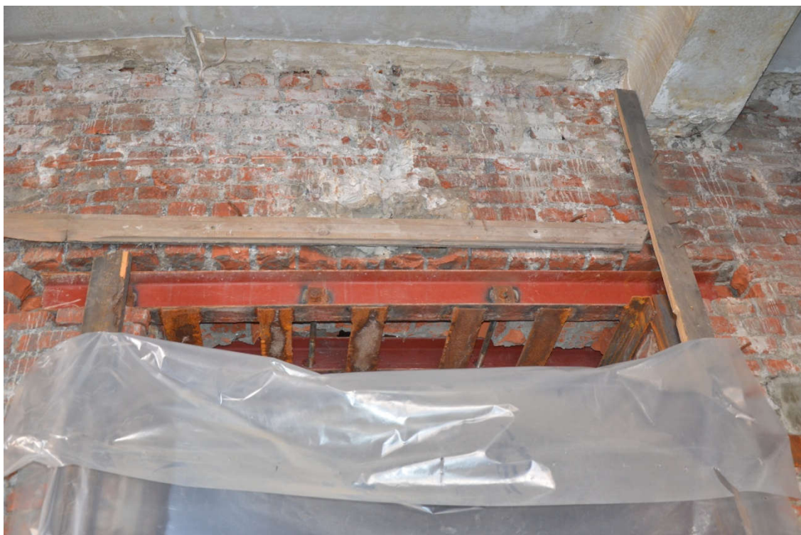
Рисунок 101 - Перемычки 3-4 на 1 этаже по оси 3
