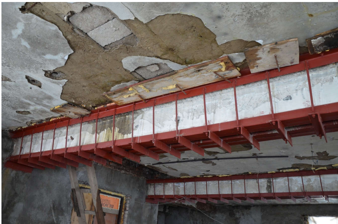
Рисунок 134 – Усиленные балки перекрытий Б-1 на 3 этаже в осях 8-13/Б-Д
