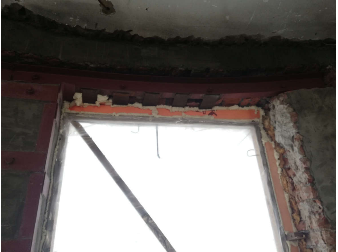
Рисунок 74 - Перемычка 33 на 3 этаже по оси 8
