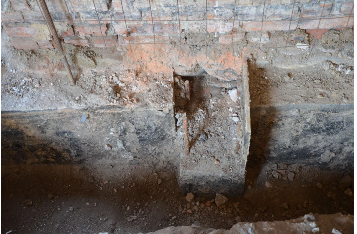
Рисунок 41 – Фундамент Ф5 в осях В-Ж/13-17
