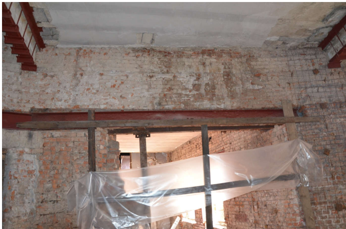
Рисунок 126 – Перемычка 01/2 на 1 этаже по оси Ж
