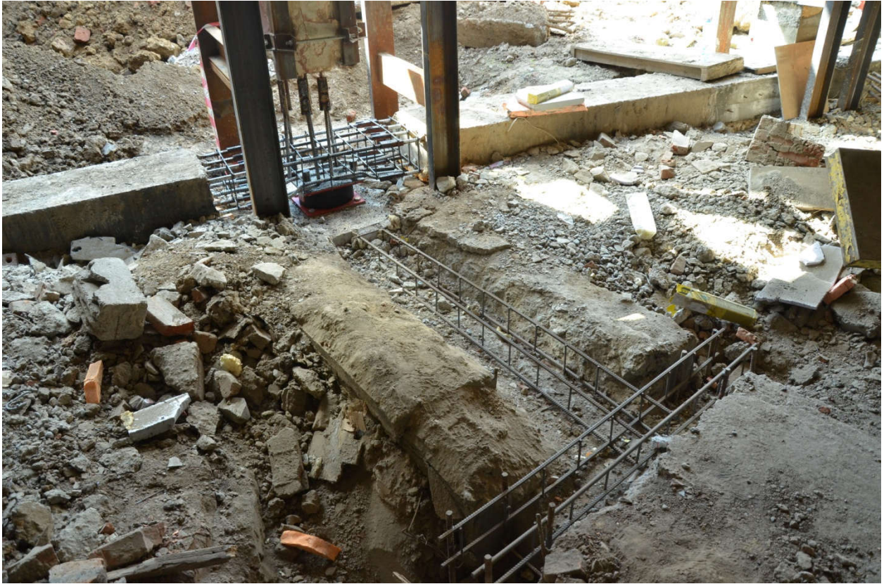
Рисунок 37 – Фундамент Ф 13 в осях Ж-И/2-3. Монтаж резинометаллической опоры
