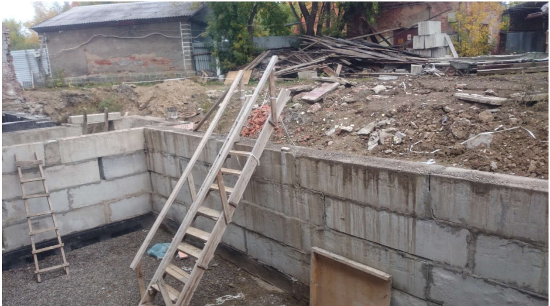
Рисунок 19 – Несоответствие раскладки блоков с рабочей документацией по оси Э
