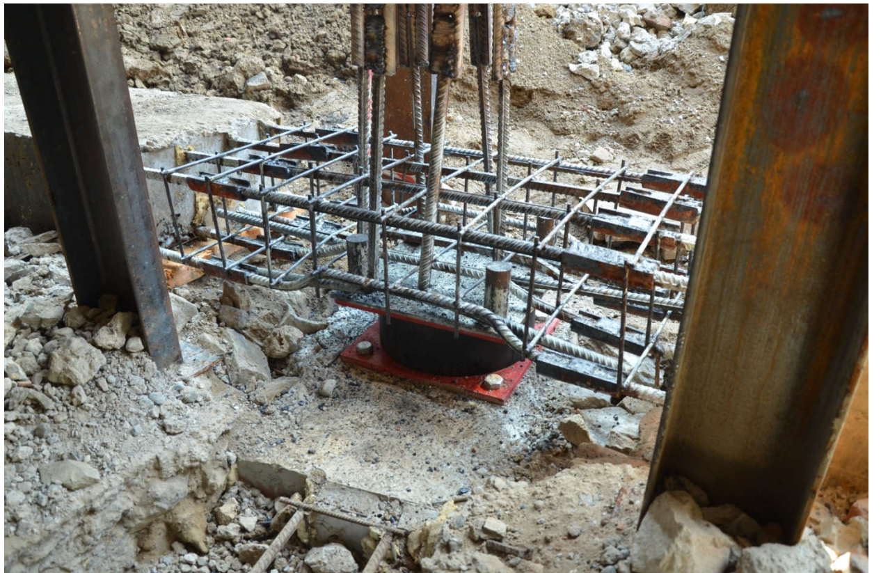
Рисунок 38 – Фундамент Ф 13 в осях Ж-И/2-3. Монтаж резинометаллической опоры
