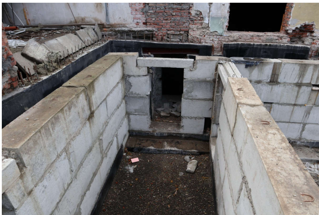
Рисунок 22 – Несоответствие раскладки блоков с рабочей документацией в осях Ф/11-12
