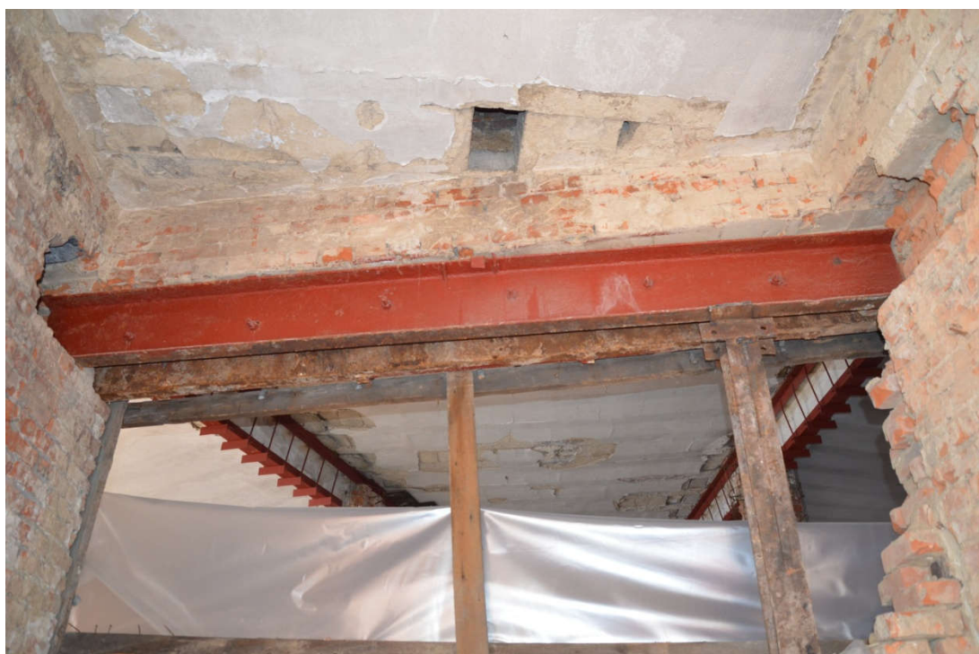
Рисунок 124 – Перемычка 01/1 на 1 этаже по оси Ж
