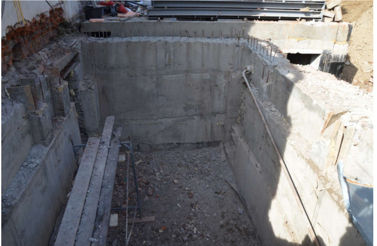
Рисунок 53 – Переделанный фундамент пристроенного помещения Ф10 в осях У-Э/13-16
