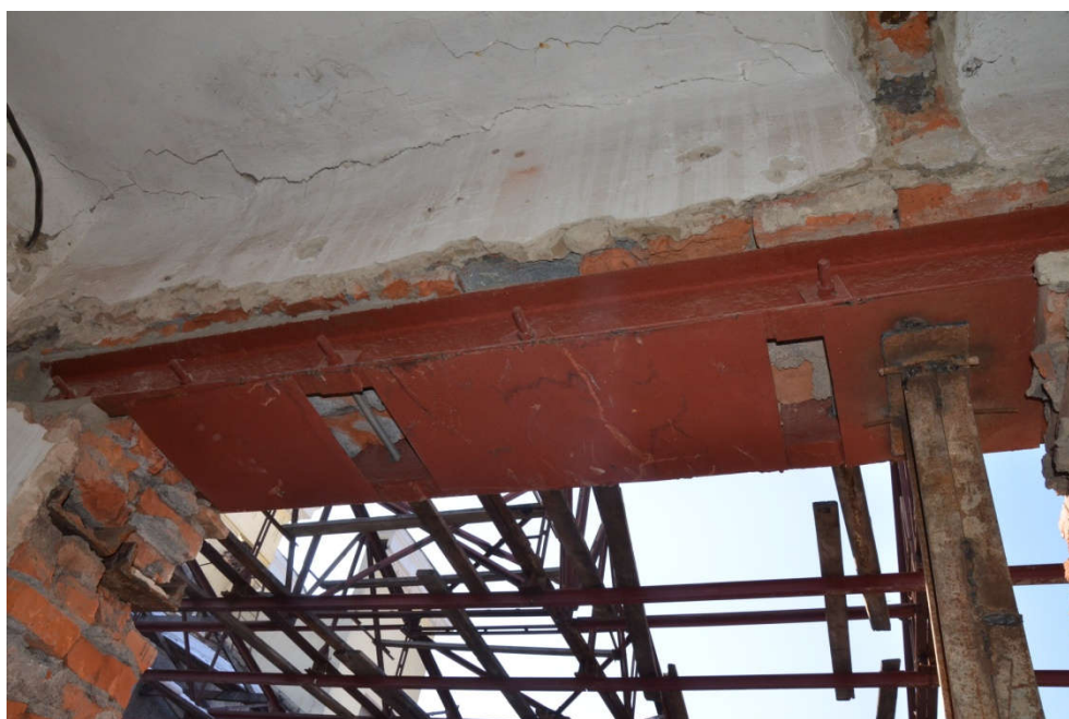
Рисунок 111 - Перемычка 20-1 на 1 этаже по оси Ж
