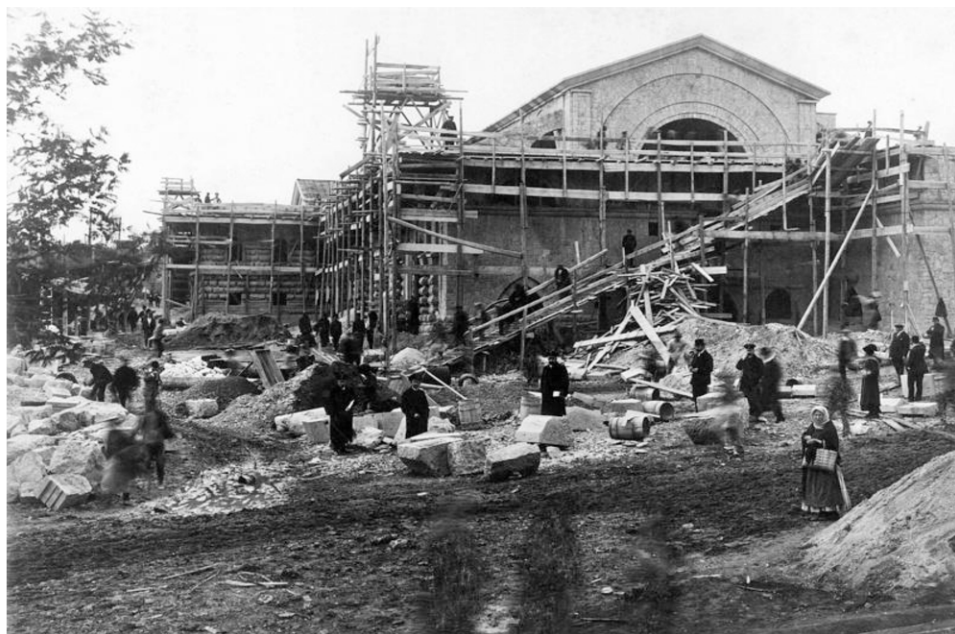
Рисунок 1.20 - Процесс сооружения Грязелечебницы
