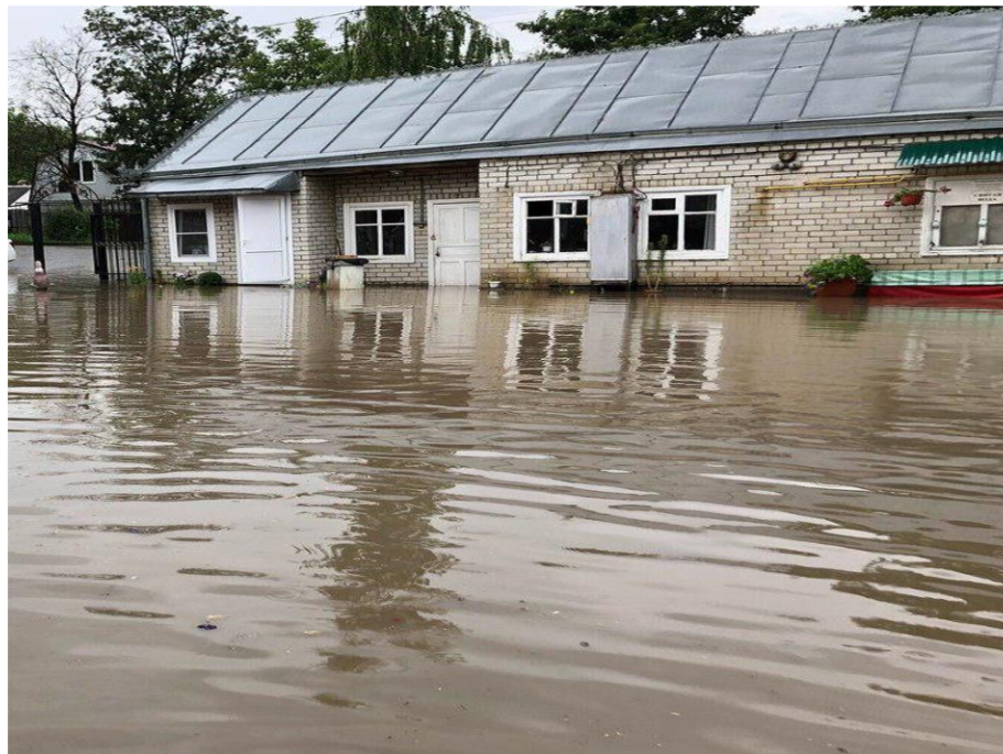
Рисунок 2.12 - Затопление части зданий при наводнении в г. Кисловодске (июль, 2018 г.)
