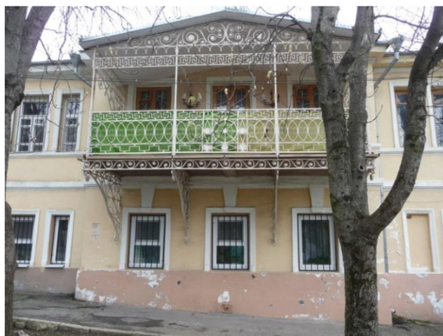
Рисунок 2.14 - Главный фасад здания
