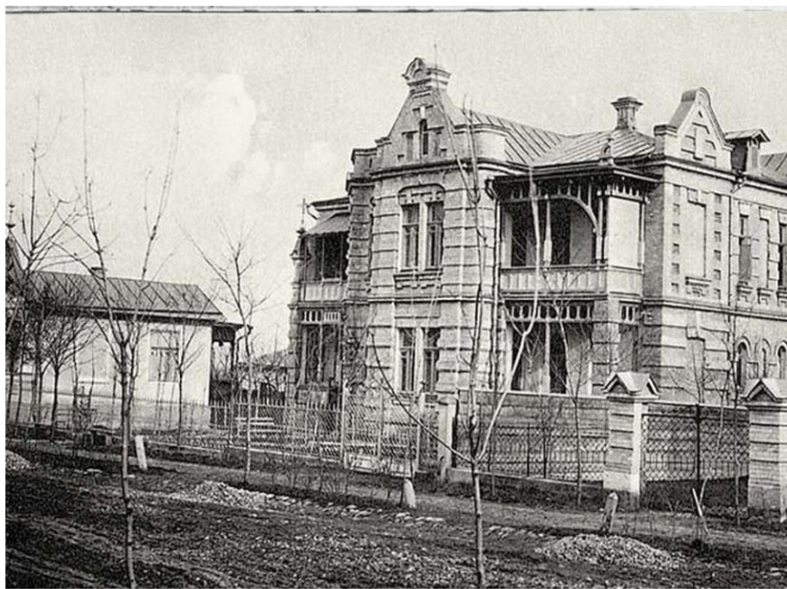
Рисунок 1.19 - Здание галереи Эссентуки № 17
