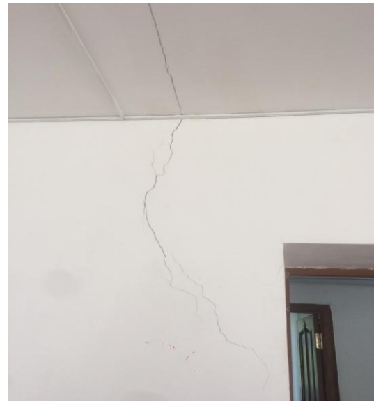
Рисунок 64 Образование трещины в стене здания администрации МО "Ахтынский район".
