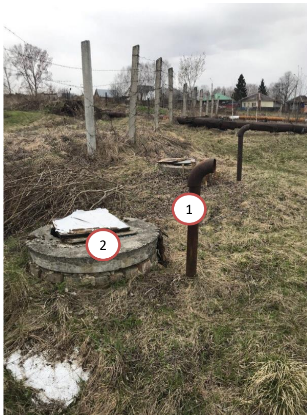
Рис.4.6 Резервуар-усреднитель 1 – вентиляционный стояк; 2 – люк
