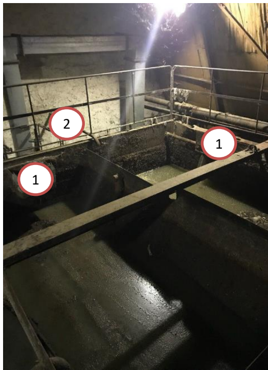
Рис.4.5 Первичный отстойник 1 – решётка для улавливания крупных включений; 2 – подача сточной жидкости
