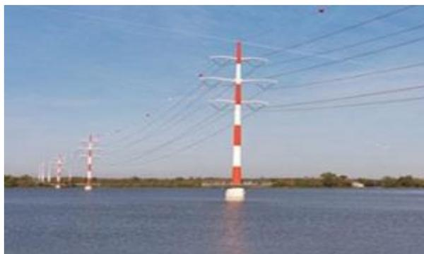
Рисунок 1.14 – Опоры трубчатые промежуточные
