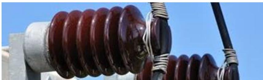
Рисунок 1.6 – Изолятор linepost
