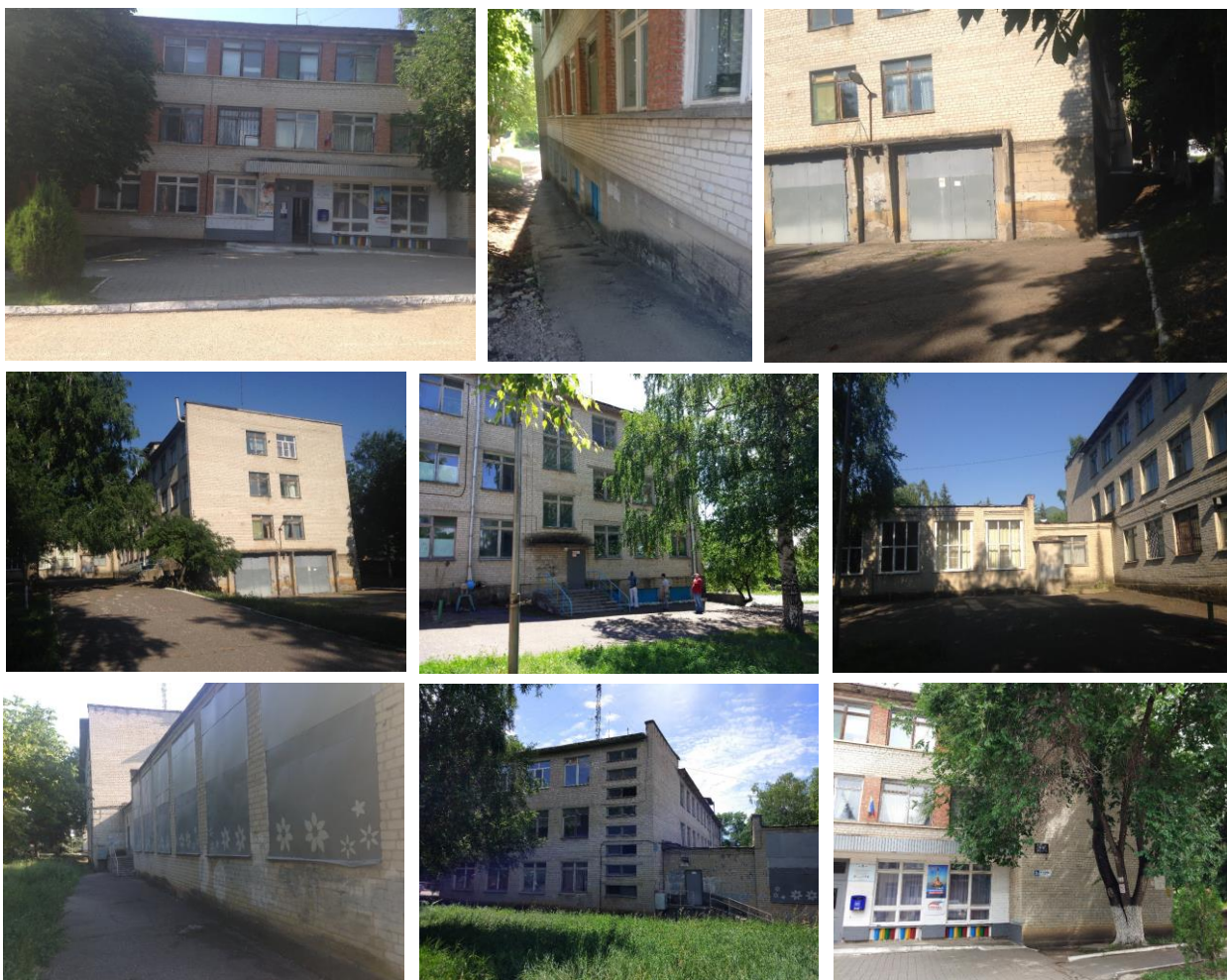
Рисунок 3.2 – Внешний вид всех сторон ЦТ “Радуга”, начиная с фасада (первое фото слева) и далее по часовой стрелке вокруг здания.
