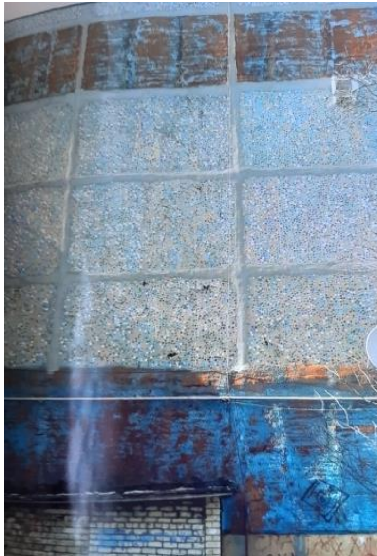
Рисунок 3.15 – Боковой фасад здания после герметизации
