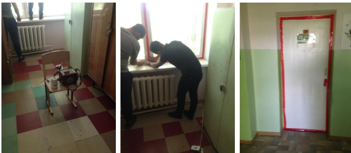
Рисунок 3.5 – Герметизация помещения № 35 в ЦТ “Радуга”
