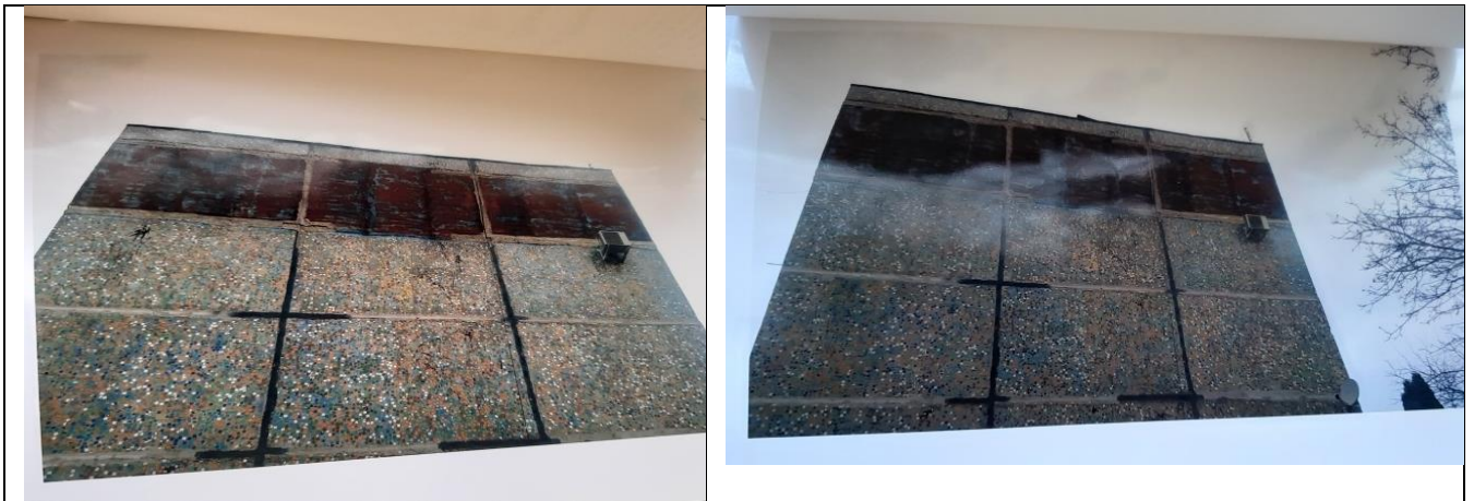
Рисунок 3.15 Боковой фасад здания до герметизации
