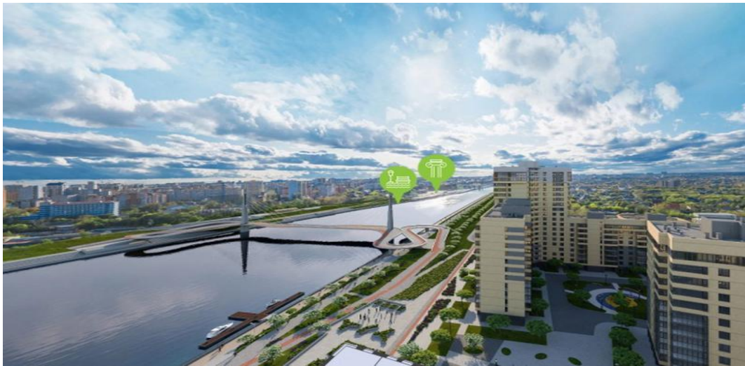
Рисунок 3.14 – Пешеходный мост через р. Туру на ул. Береговой
